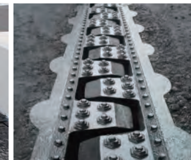
▲伸縮装置の表面 自由な造形性により表面を半円形状にし、スリップ防止対策も実現されている。
