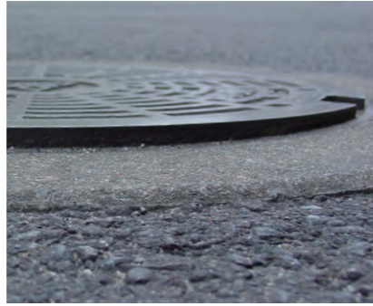
▲ふた枠との段差
