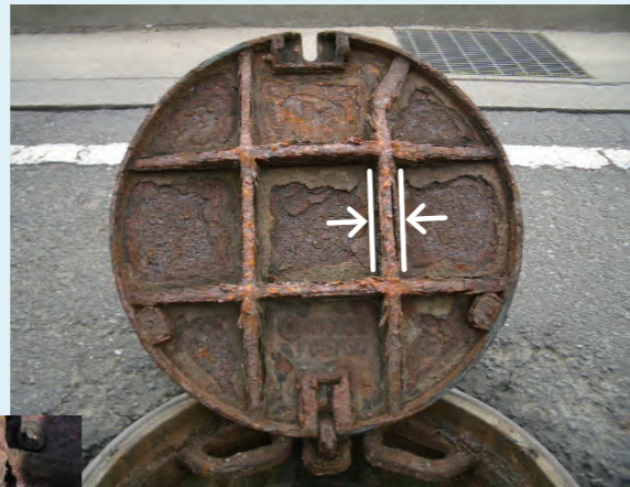
▲腐食でリブが減り強度低下
