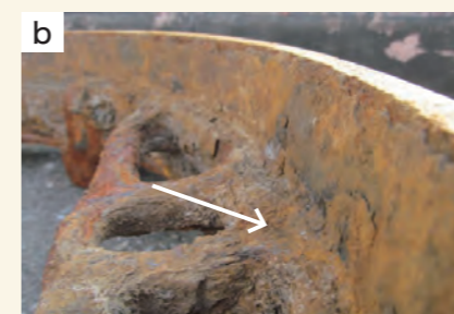
▲枠勾配面の腐食生成物堆積
