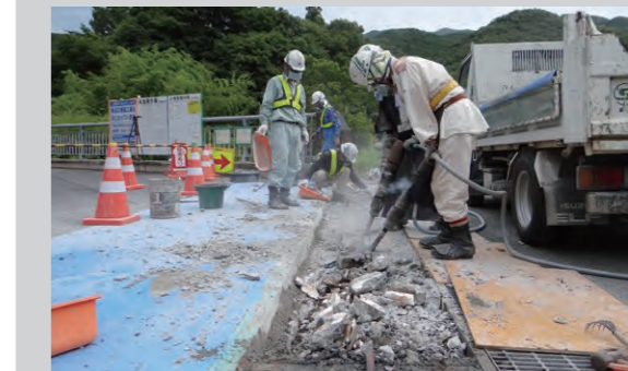
▲コンクリートはつりや鉄筋切断での作業負担
