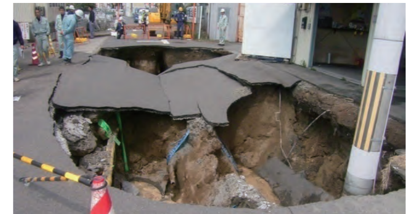
▲下水管きよの破損による道路陥没(延長15m、深さ5m)
