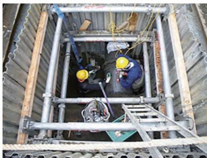
▲開削管体調査の様子
