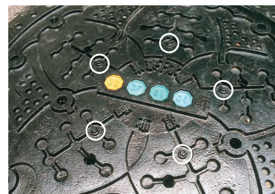
▲スリップサイン(丸で囲った箇所)3mm減ったら交換の目安
