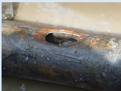
▲管体の腐食の例
