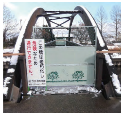
▲老朽化により通行止めとなった橋梁
