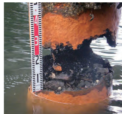
▲鋼製杭橋脚が著しく腐食(通行止め)
