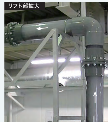
▲垂直方向に重量物(管内の黒い部分)が運搬されている
