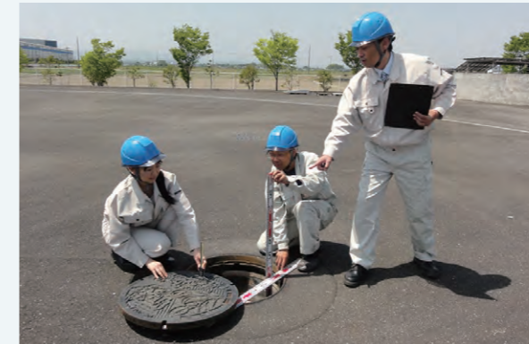
▲マンホールふた調査による性能評価
