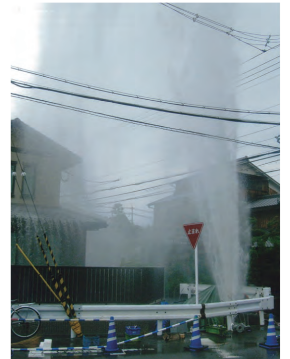
▲水道管の老朽化が時には甚大な事故を招く（2014年9月3日付・京都新聞掲載/京都市山科区）
