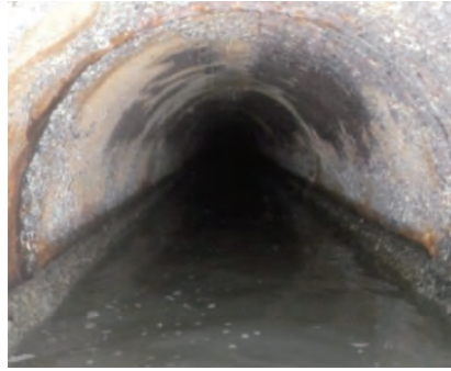
▲腐食の進んだ管きよ（提供：国土交通省）
