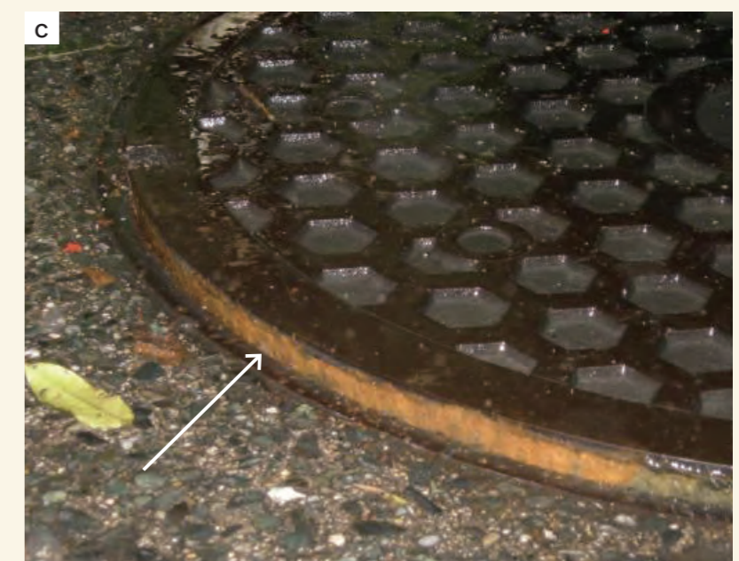
▲段差の発生(急勾配受け構造)
