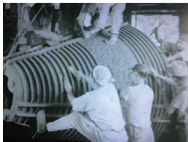
▲延べ123人が製作に関わり、使用した型枠は6.5tにも及びます。 (提供：川口鑄物工業協同組合／池田美術株式会社、撮影：池田甚兵衛氏)
