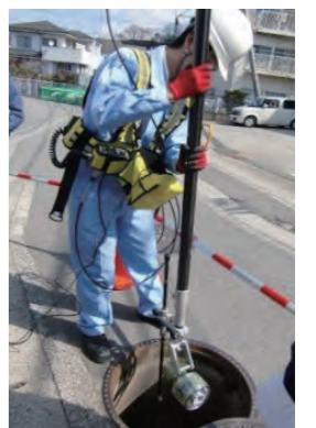
▲下水道路の管口カメラ調査
