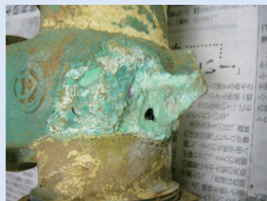
▲バルブの腐食の例
