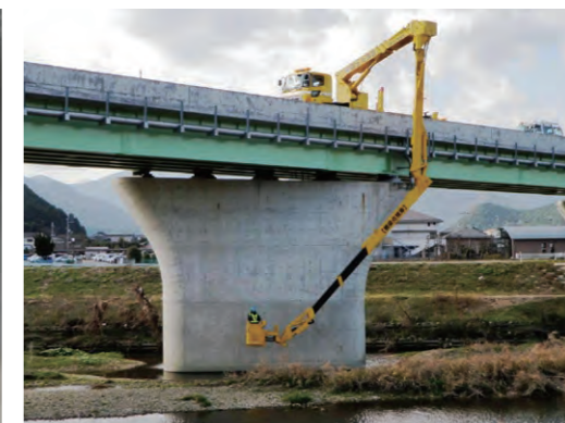
▲点検車による橋脚の点検
