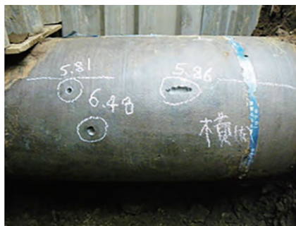
▲管体の表面に腐食孔を発見
