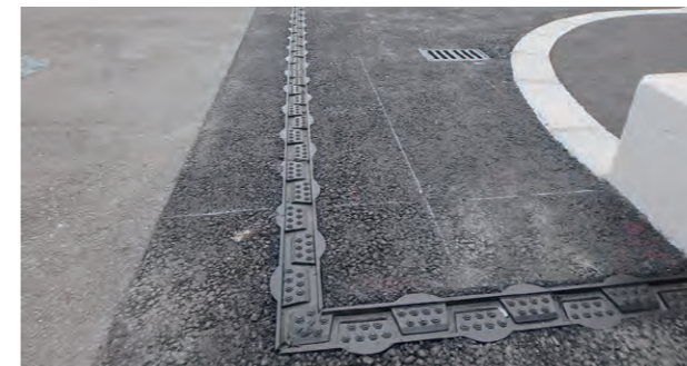
▲鋳物製橋梁伸縮装置 高い剛性により、コンクリートによる補強が不要に。
