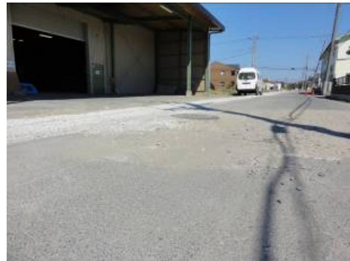
車道部のマンホール 補修跡あり
