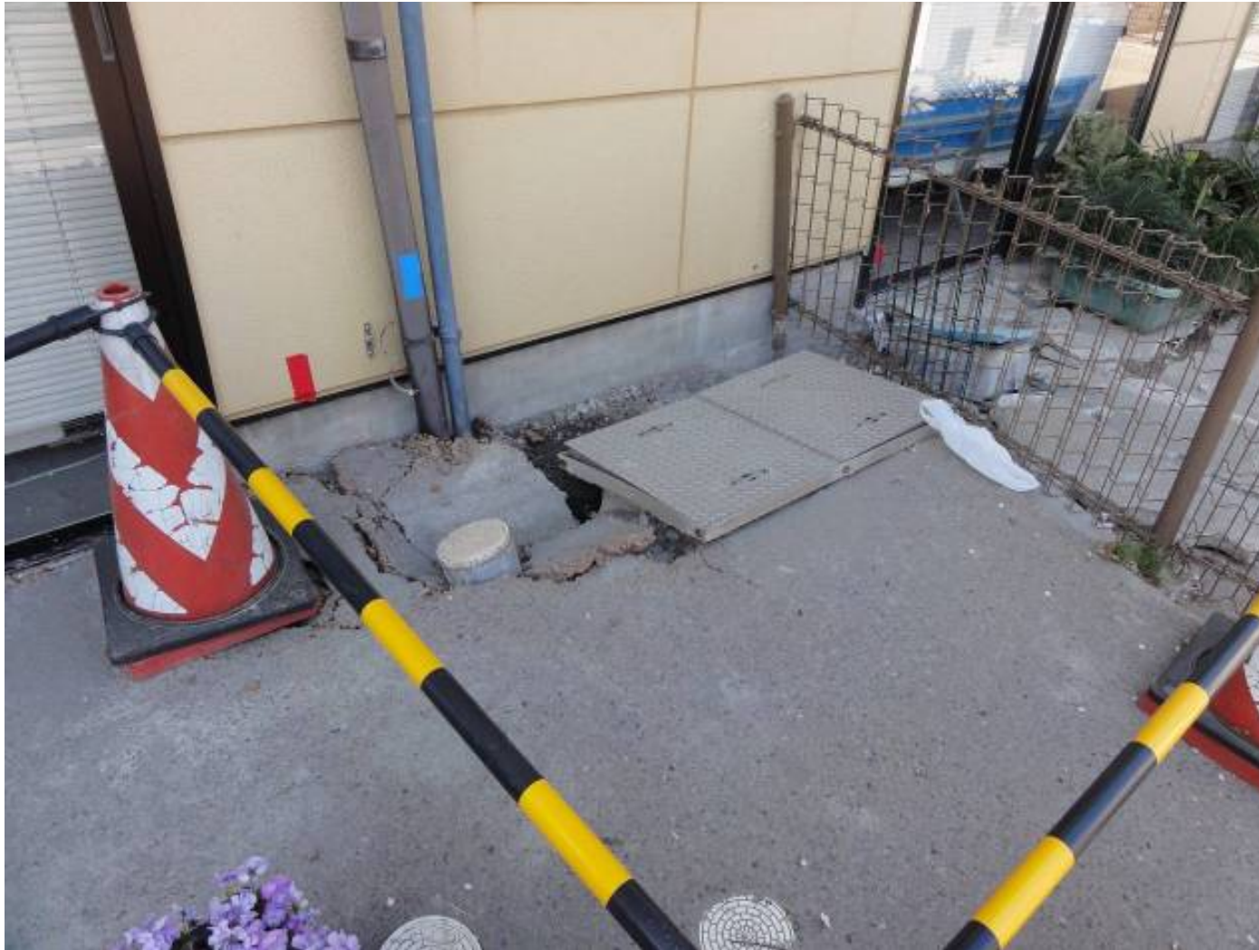
汚水枡部の隆起とふたのズレ
