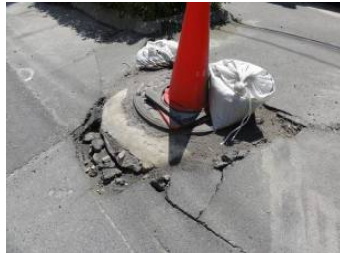
歩道部のマンホールの浮上
