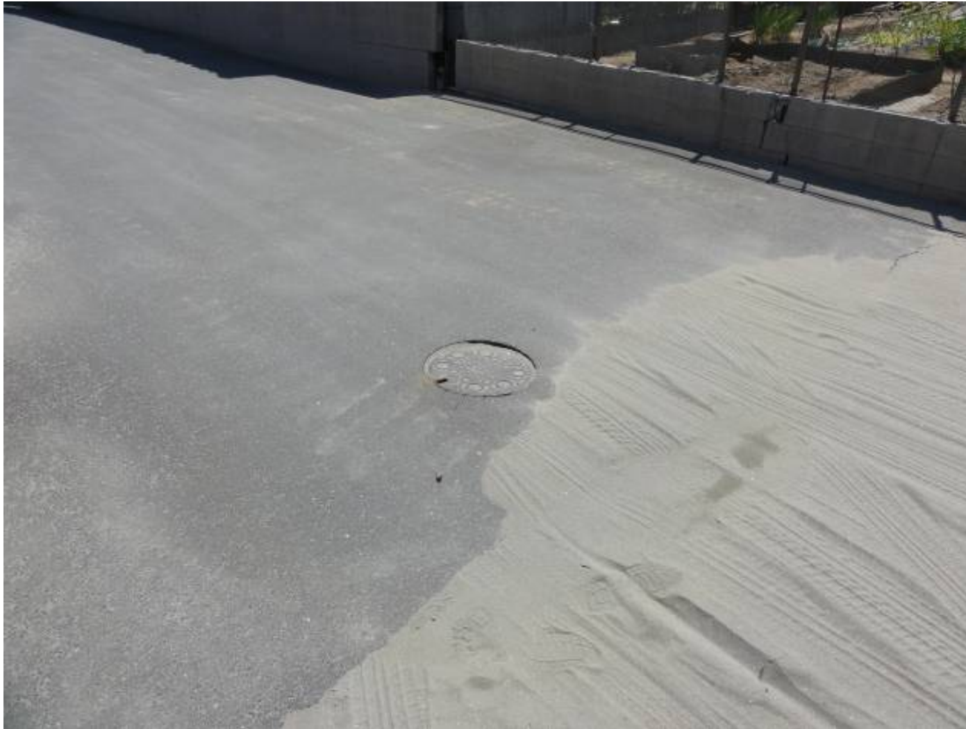
車道部の小型マンホール 傾斜
