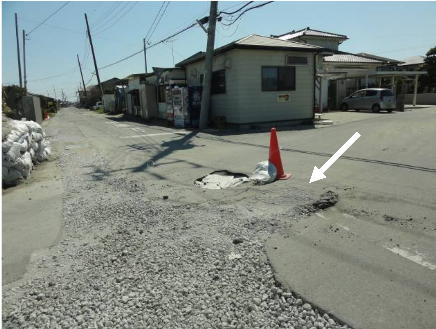
車道部のマンホール 周辺舗装に陥没あり
