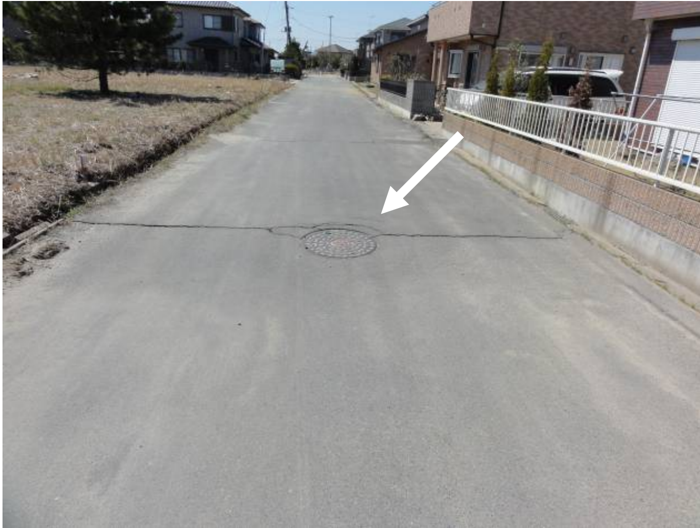
周辺舗装の横断方向ひび割れ
