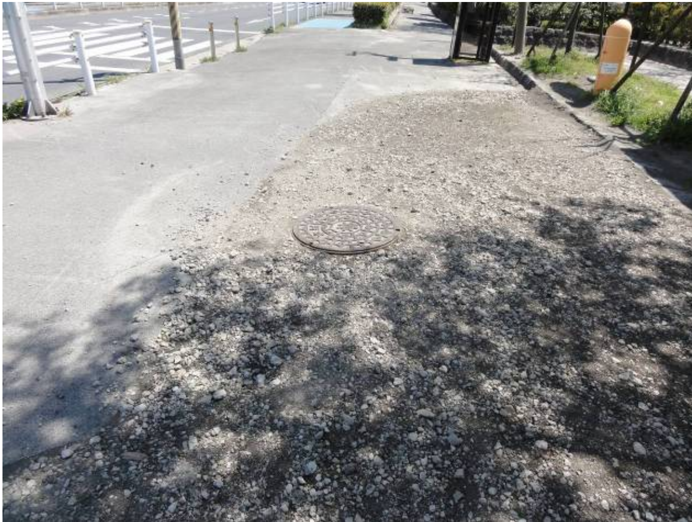
歩道部のマンホール周辺舗装補修跡あり
