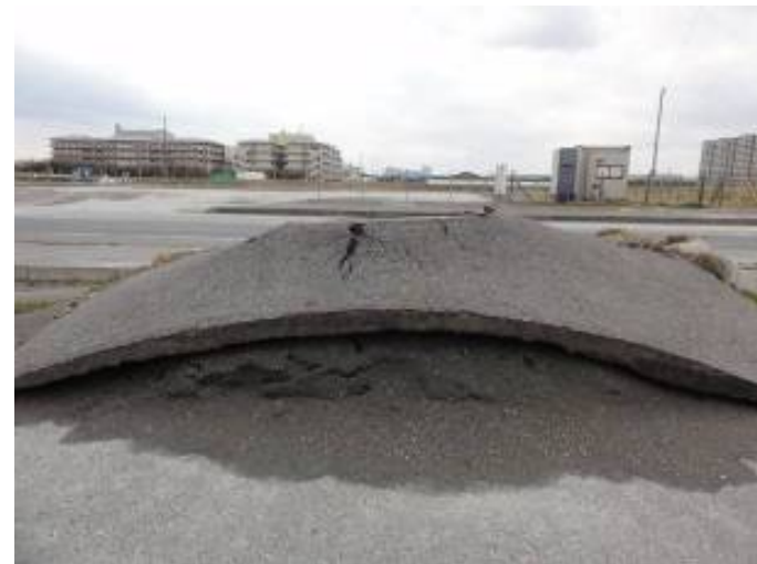
歩道部のマンホールの浮上
