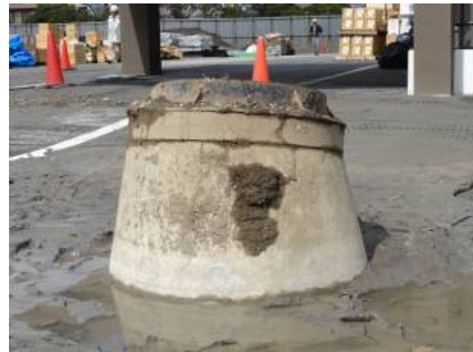
歩道部北側のマンホールの浮上 液状化噴砂
