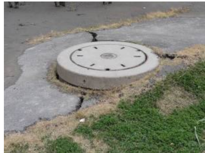
噴砂と汚水枘周辺のひび割れ
