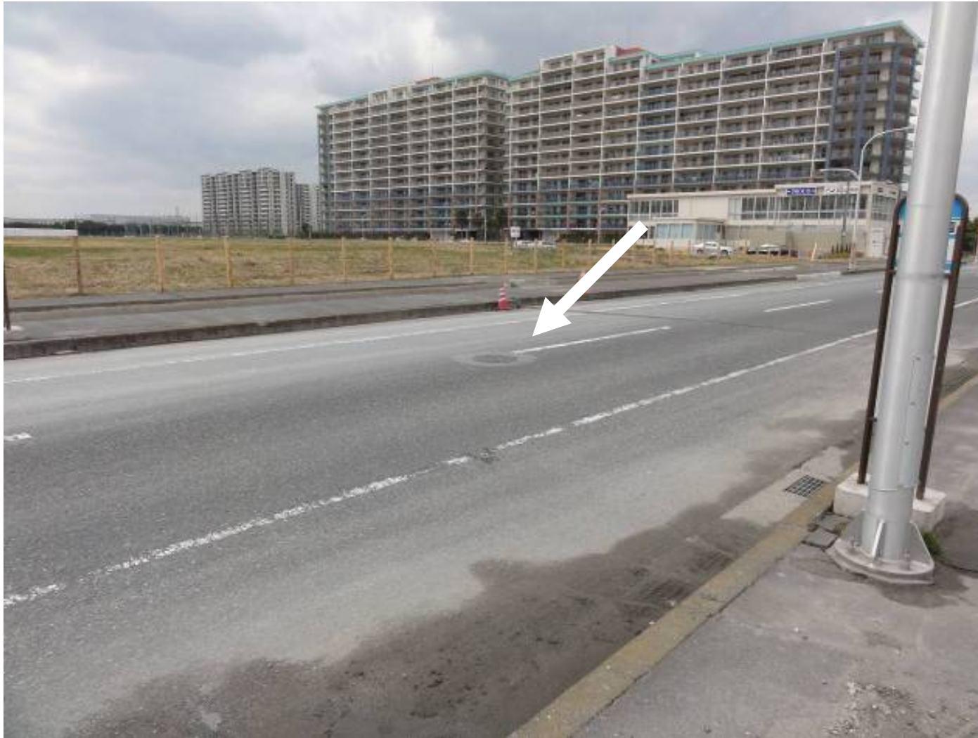
車道部のマンホール 特に問題なし
