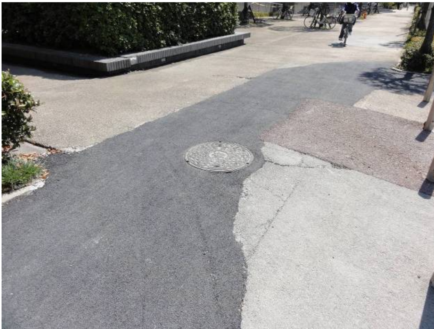
歩道部のマンホール 周辺舗装に補修跡あり
