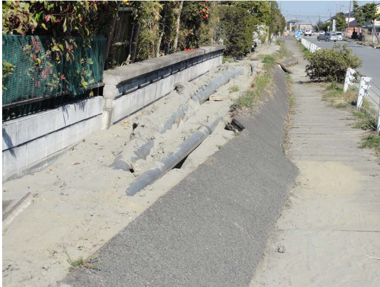
管渠(汚水、水道)が浮上 潮来市日の出
