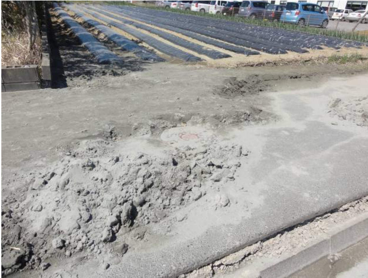
歩道部のマンホール 噴砂に埋もれている
