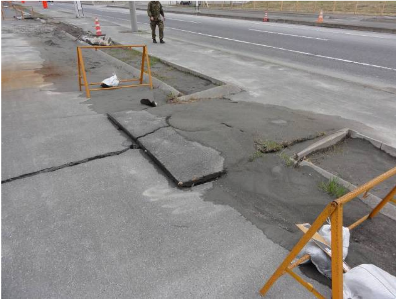
歩道部のマンホールの浮上
