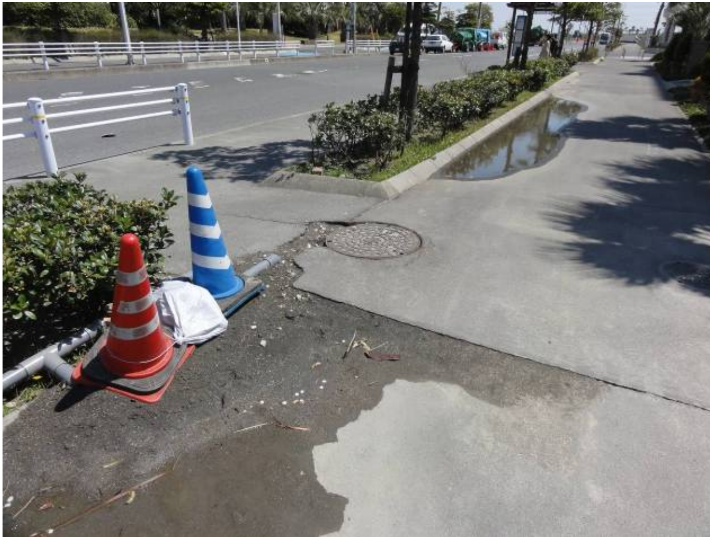
歩道部のマンホール周辺舗装が一部破損
