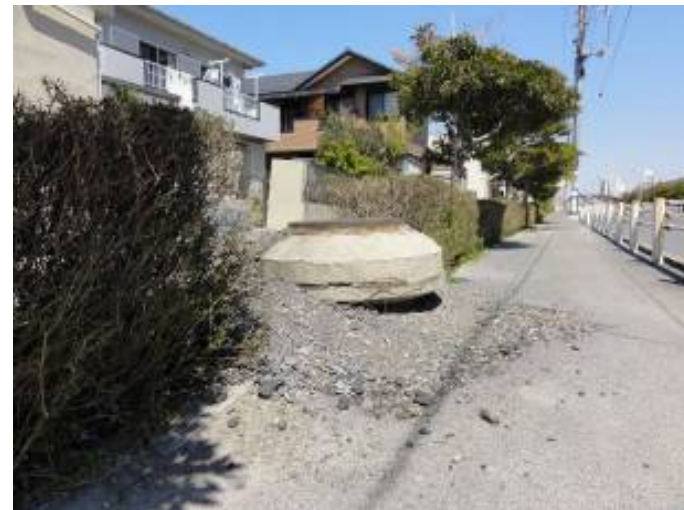
歩道部のマンホールの浮上
