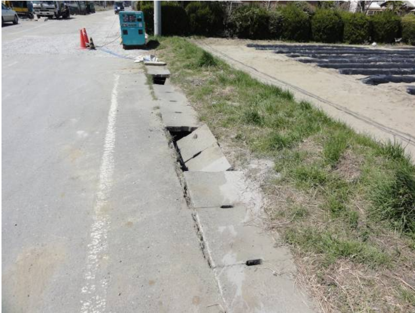
雨水側溝 ふたの脱落
