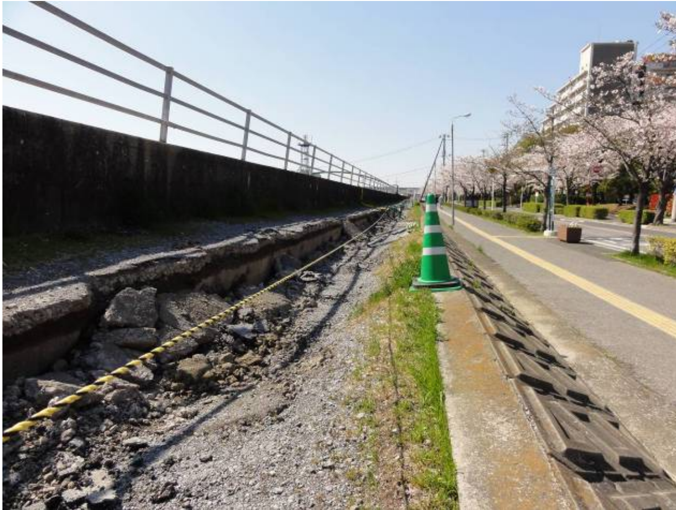
境川付近の段差
