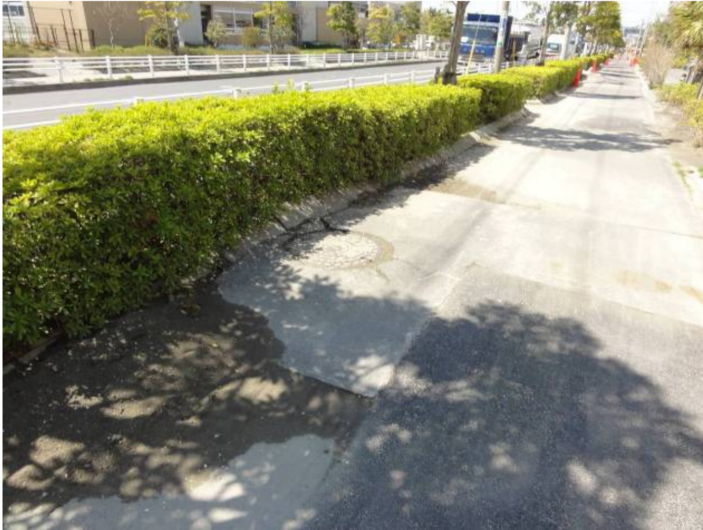
歩道部のマンホールの隆起
