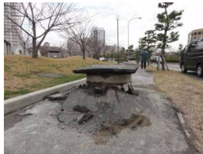
歩道部のマンホールの浮上
