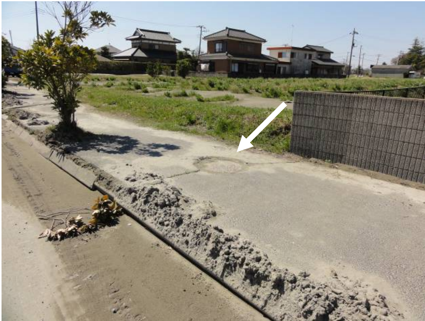
歩道部のマンホール 横断方向舗装ひび割れ
