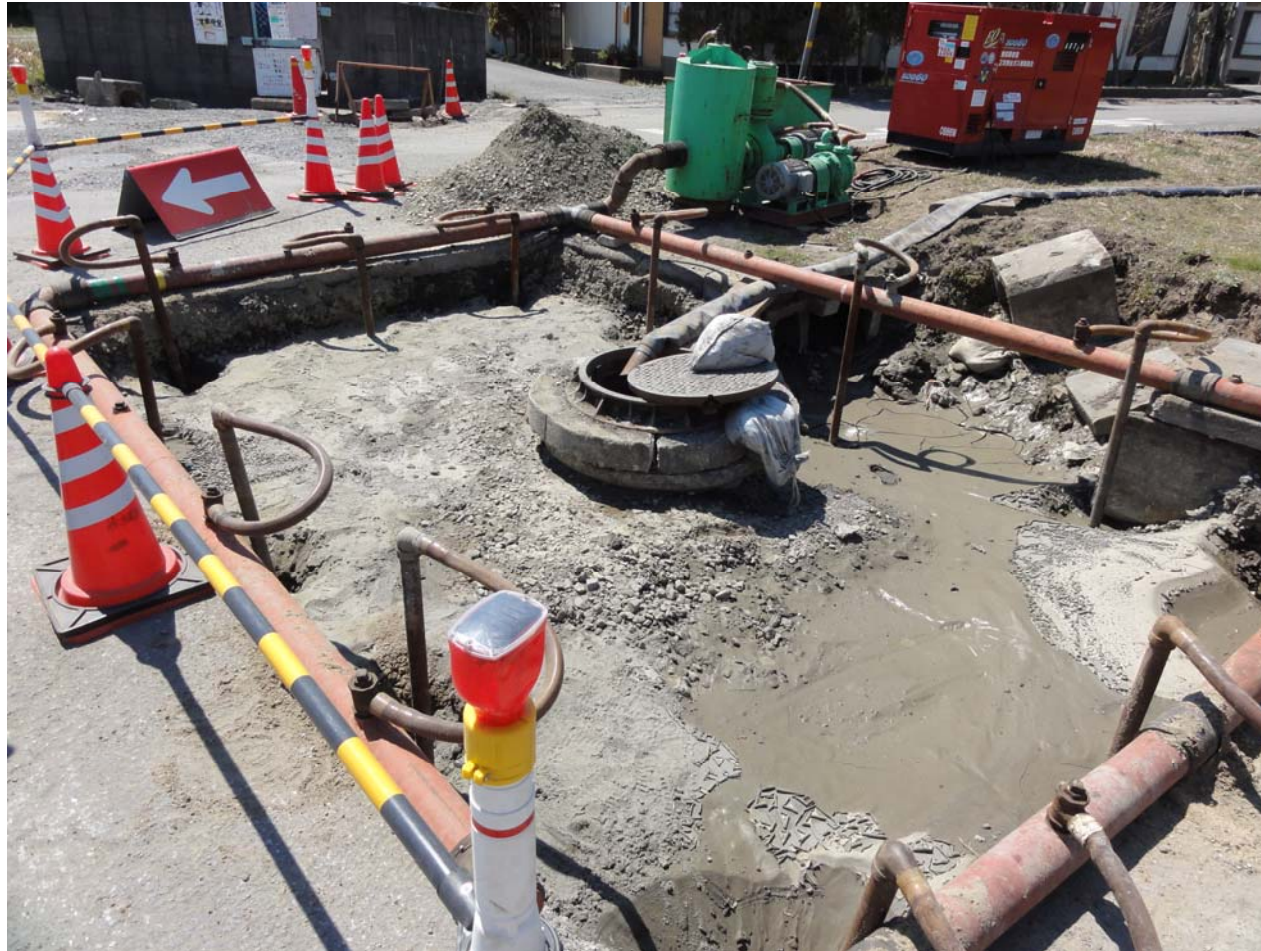
車道部のマンホール 地下水を排出 潮来市日の出
