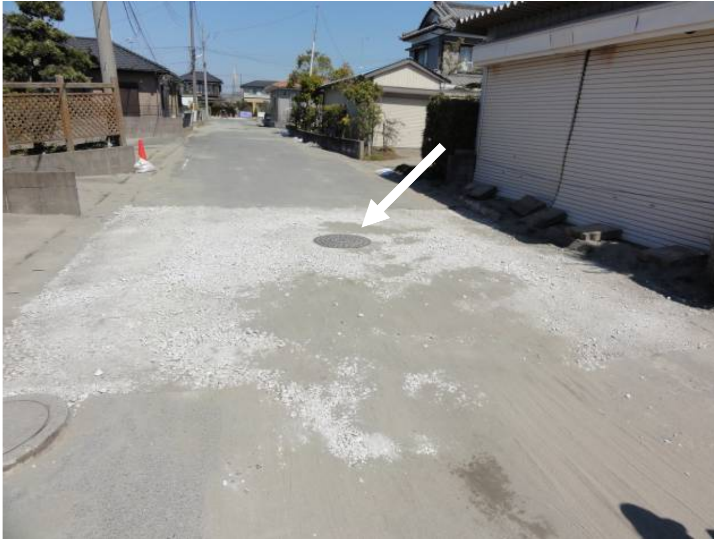
車道部のマンホール 周辺舗装補修跡
