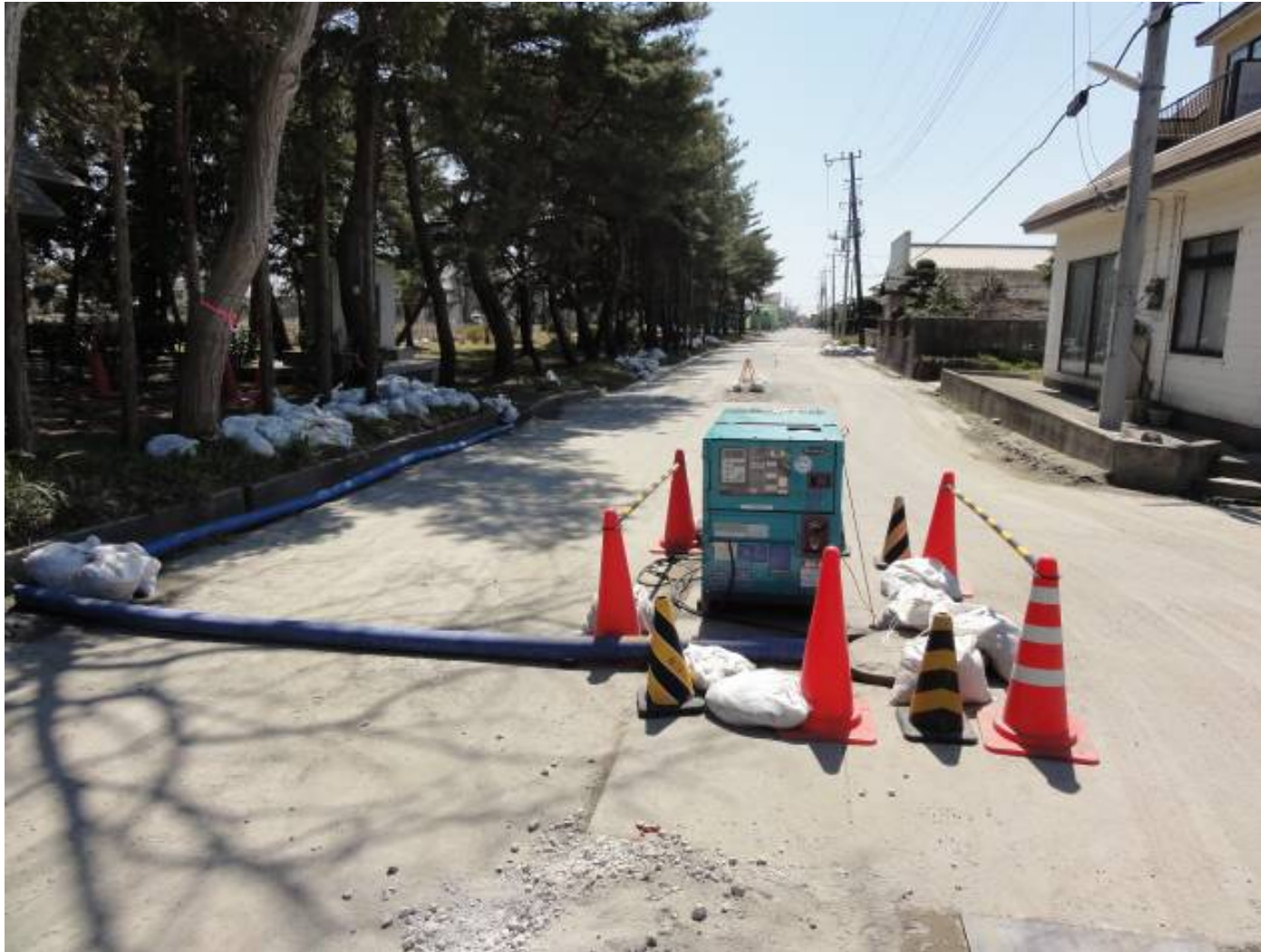
車道部のマンホール 噴砂跡あり
