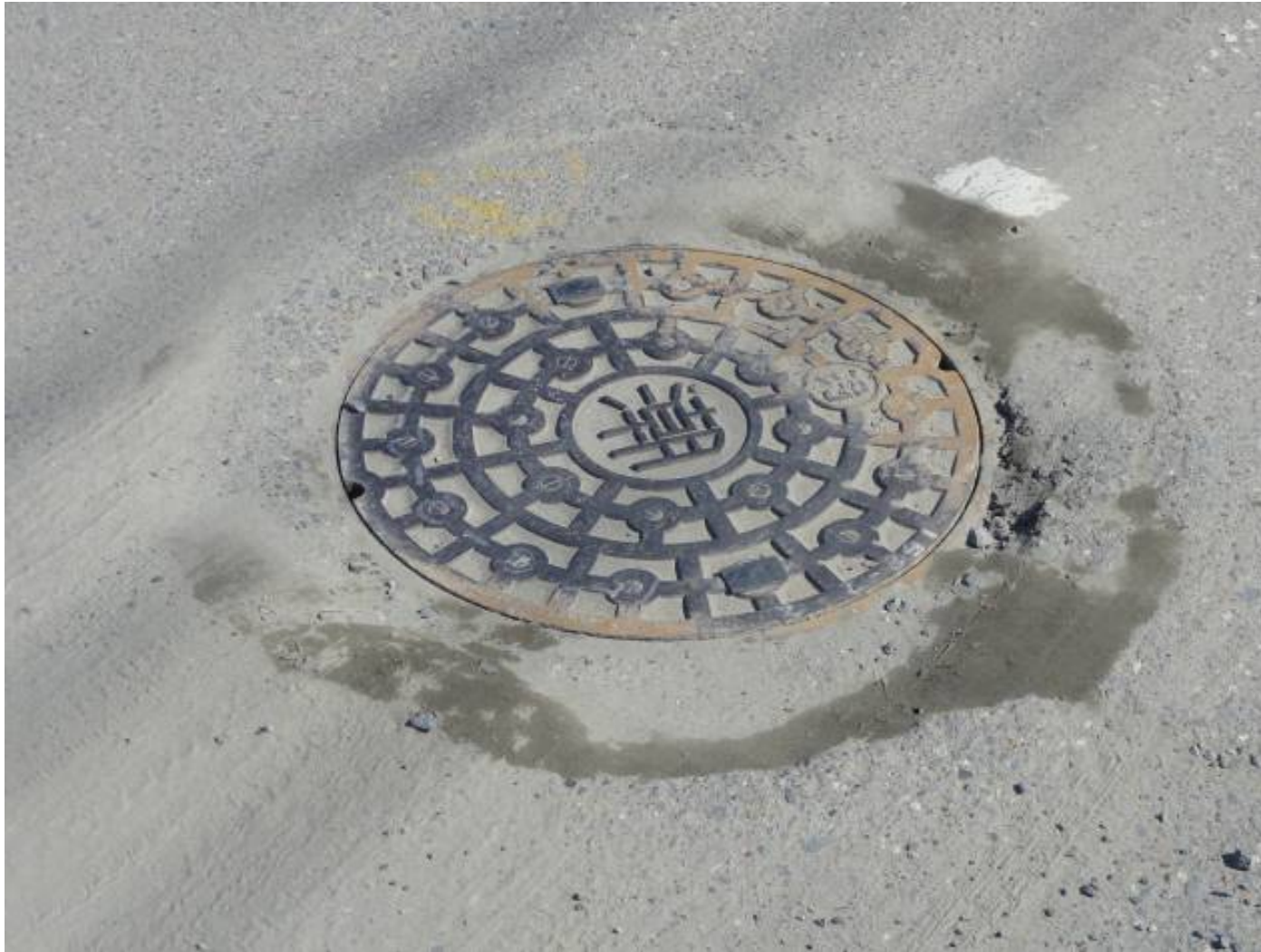
車道部のマンホール 噴砂の跡あり
