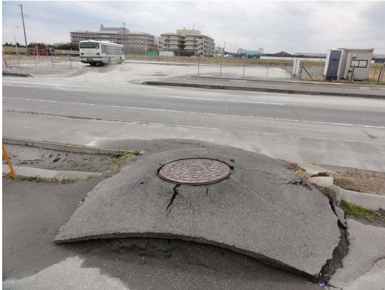
歩道部の下水道用マンホールの浮上 浦安市高洲
