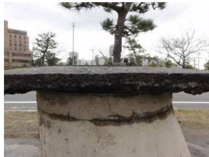
歩道部のマンホールの浮上 液状化噴砂
