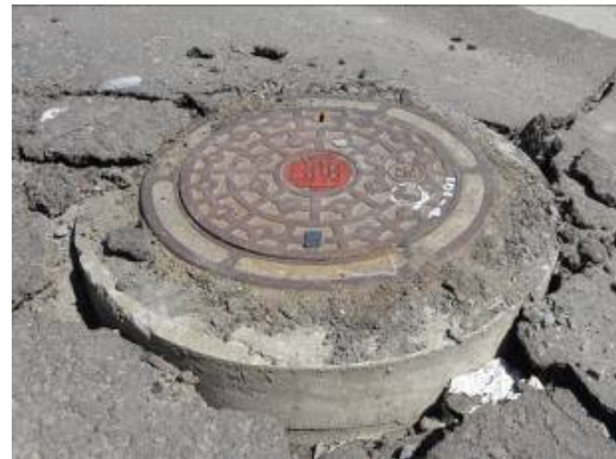
歩道部のマンホール隆起、周辺舗装破損あり
