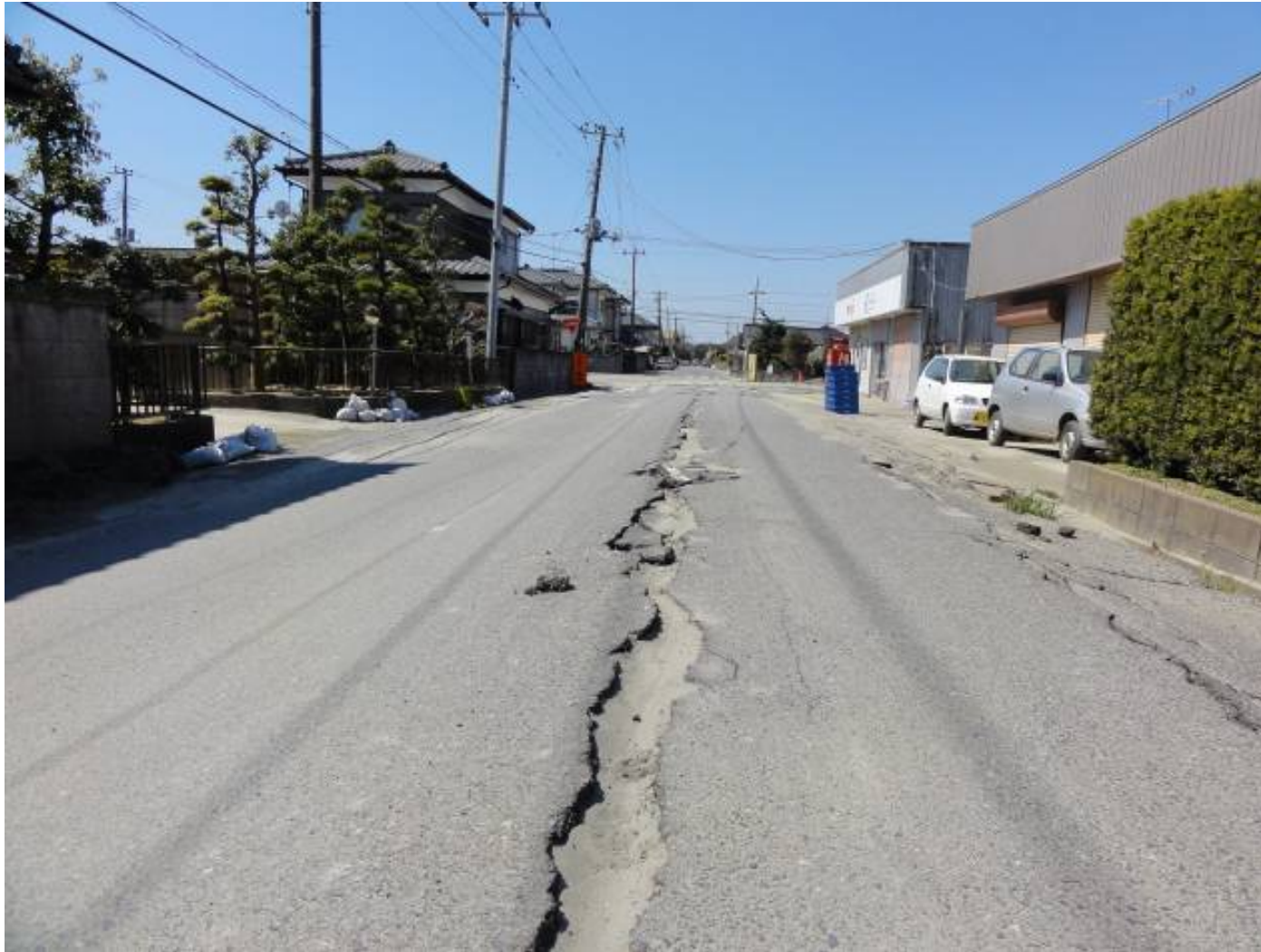
縦断方向の舗装のひび割れ
