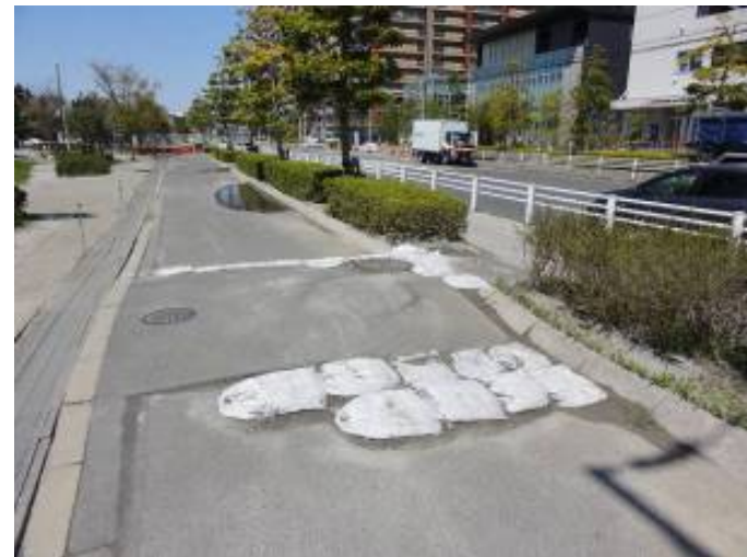
歩道部のマンホールの浮上
