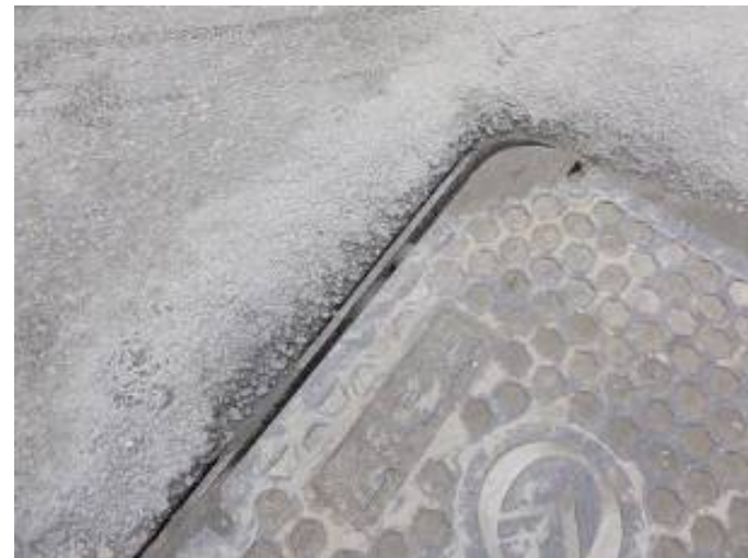
歩道部のガスボックス用蓋の枠の変形とふたの浮き上がり
