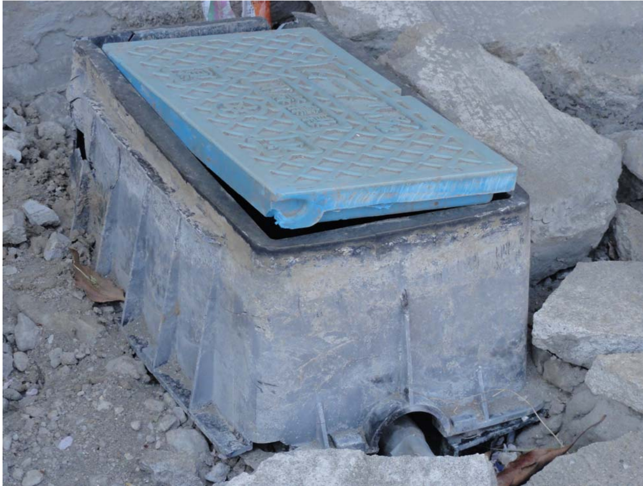
メータボックスの枠の変形、ふたの外れ、 周辺コンクリートの破損 浦安市若潮公園周辺
