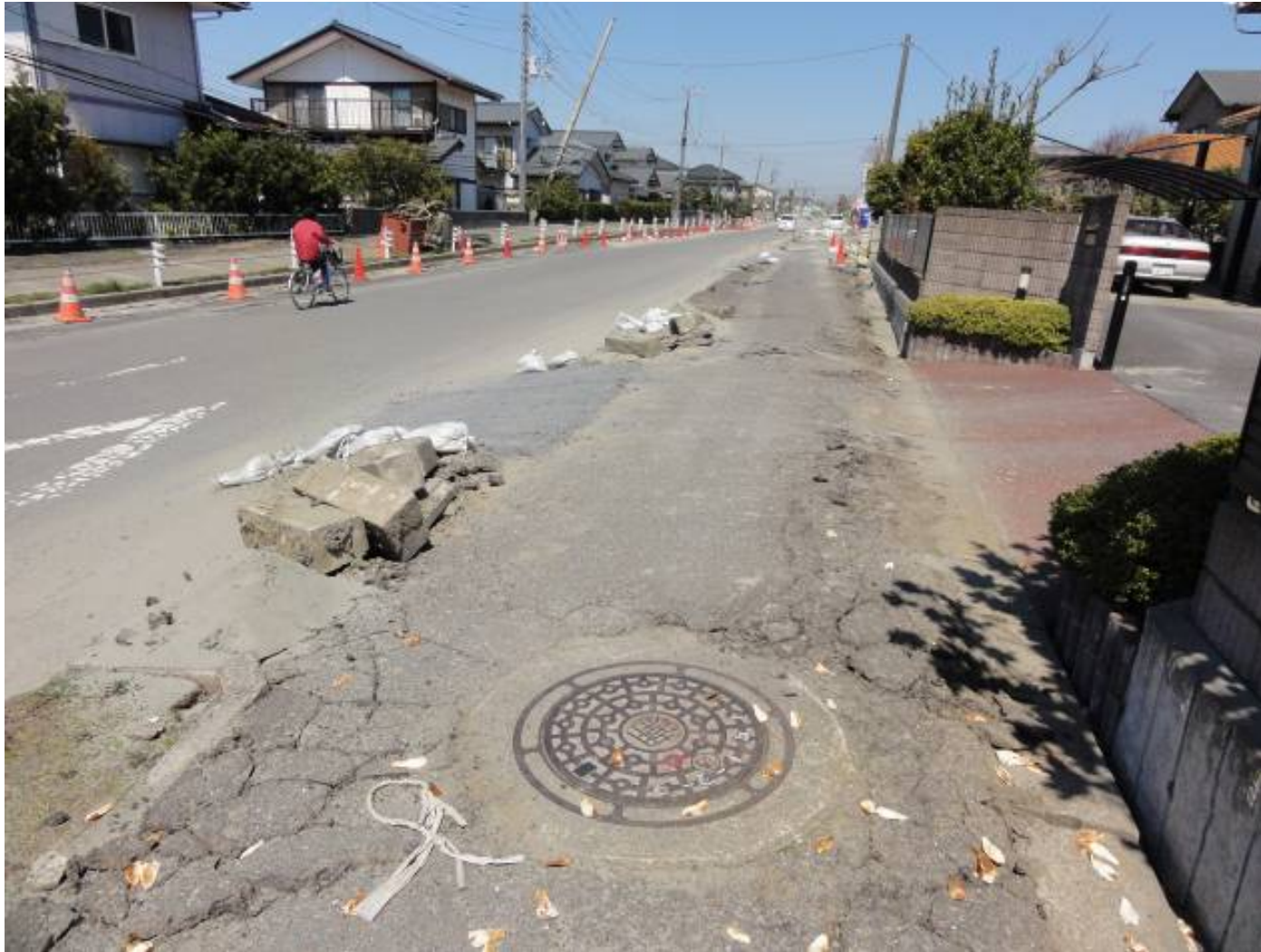
歩道部のマンホール 周辺舗装の破損
