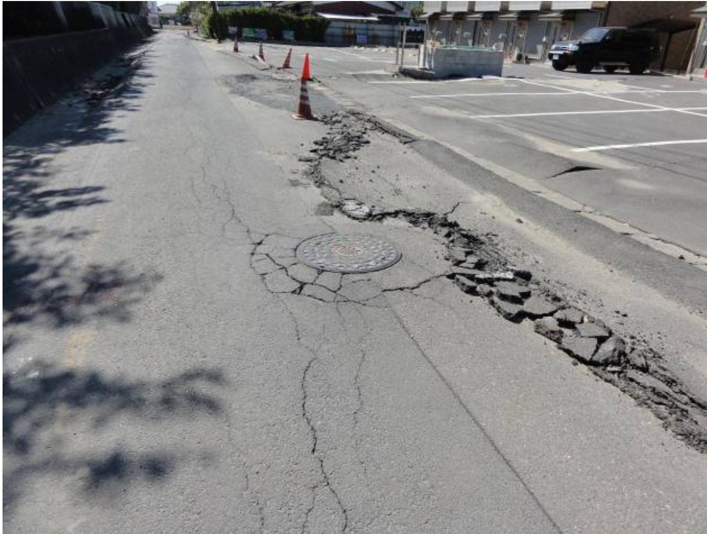
車道部のマンホール周辺舗装のひび割れ
