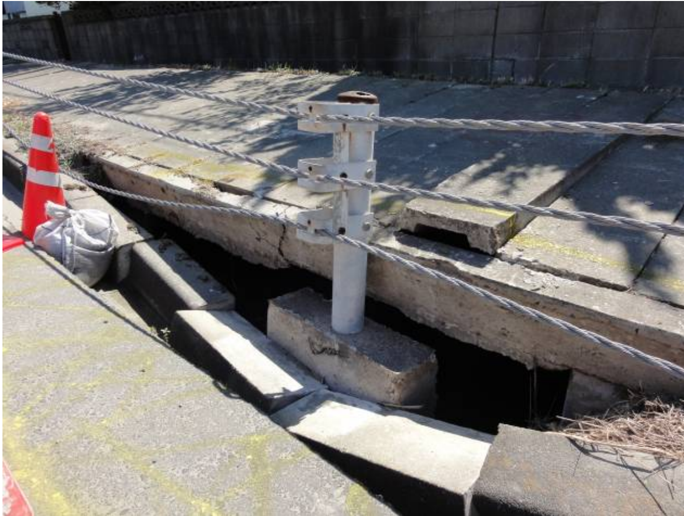
雨水側溝 破損
