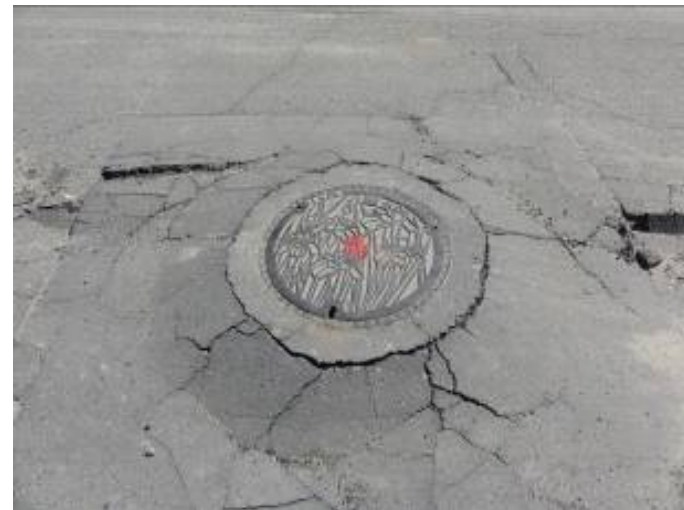
車道部のマンホールの隆起
