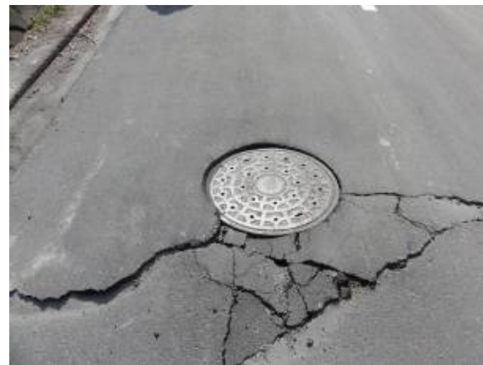
マンホールの隆起と横断方向のひび割れ
