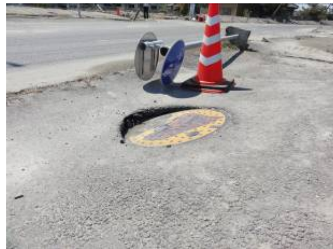
歩道部の消火栓ボックスの陥没
