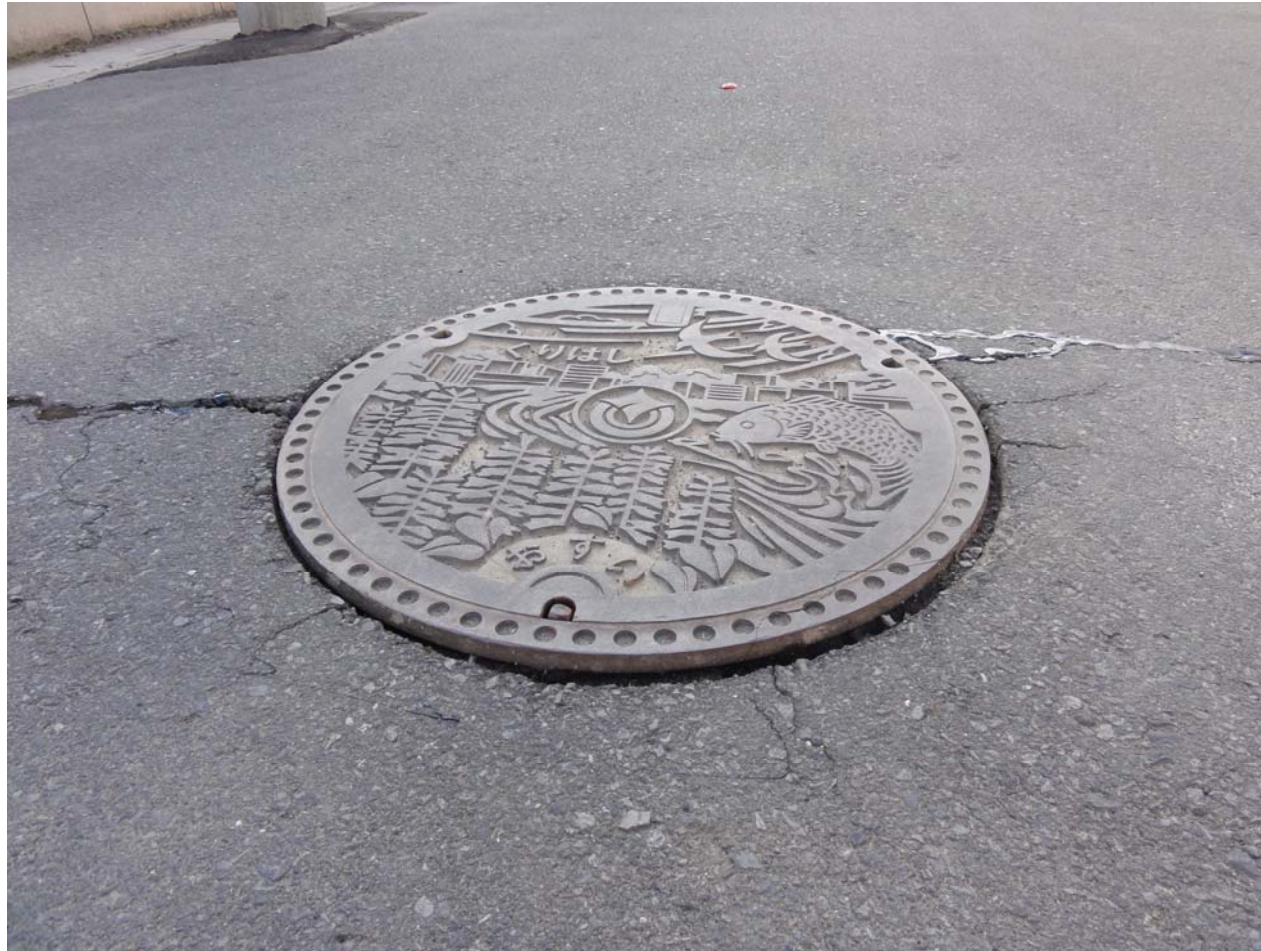
車道部のマンホール周辺舗装の段差
