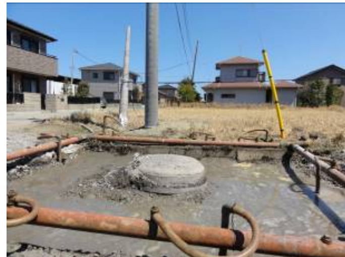
車道部のマンホール 地下水を排出
