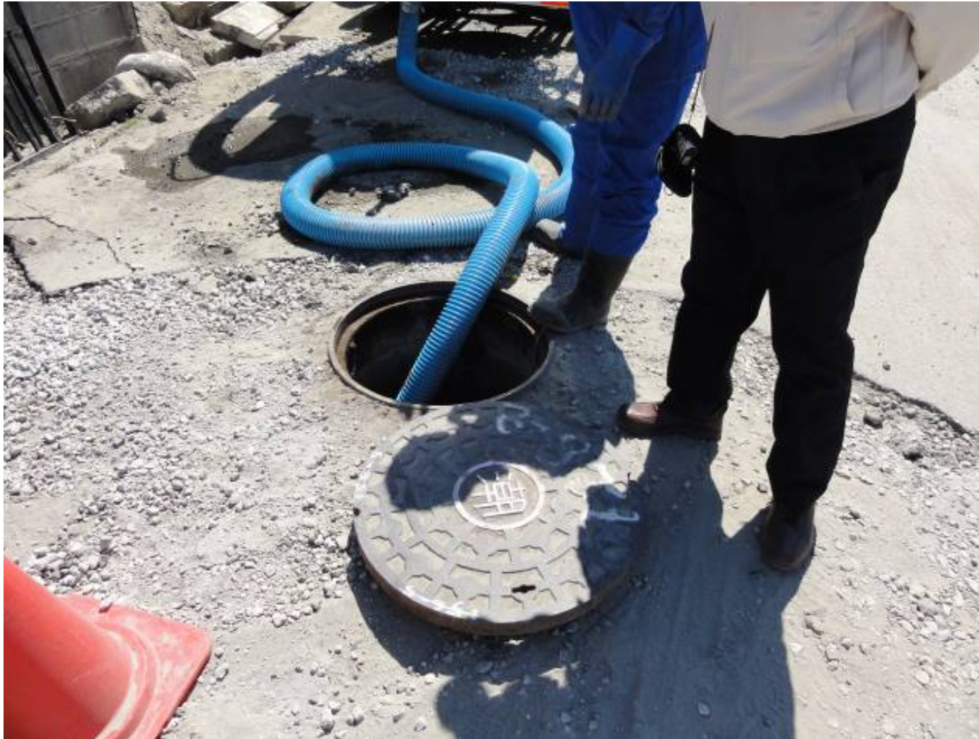
車道部のマンホール 補修跡あり
