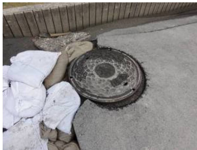
歩道部のマンホールの浮上
