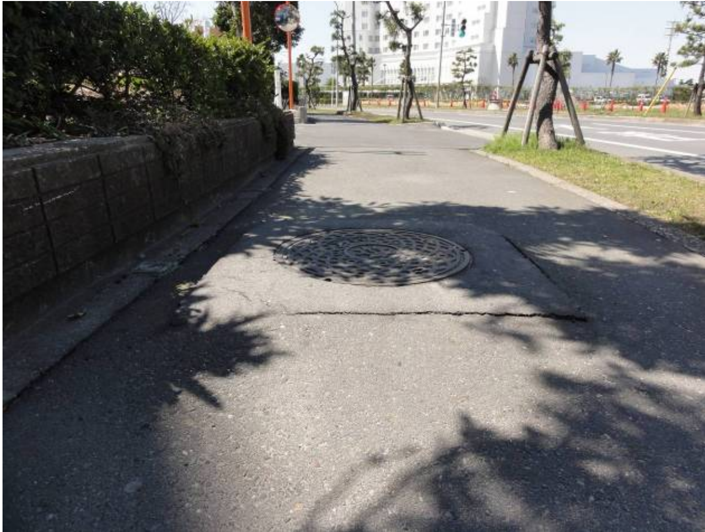
歩道部のマンホールの隆起
