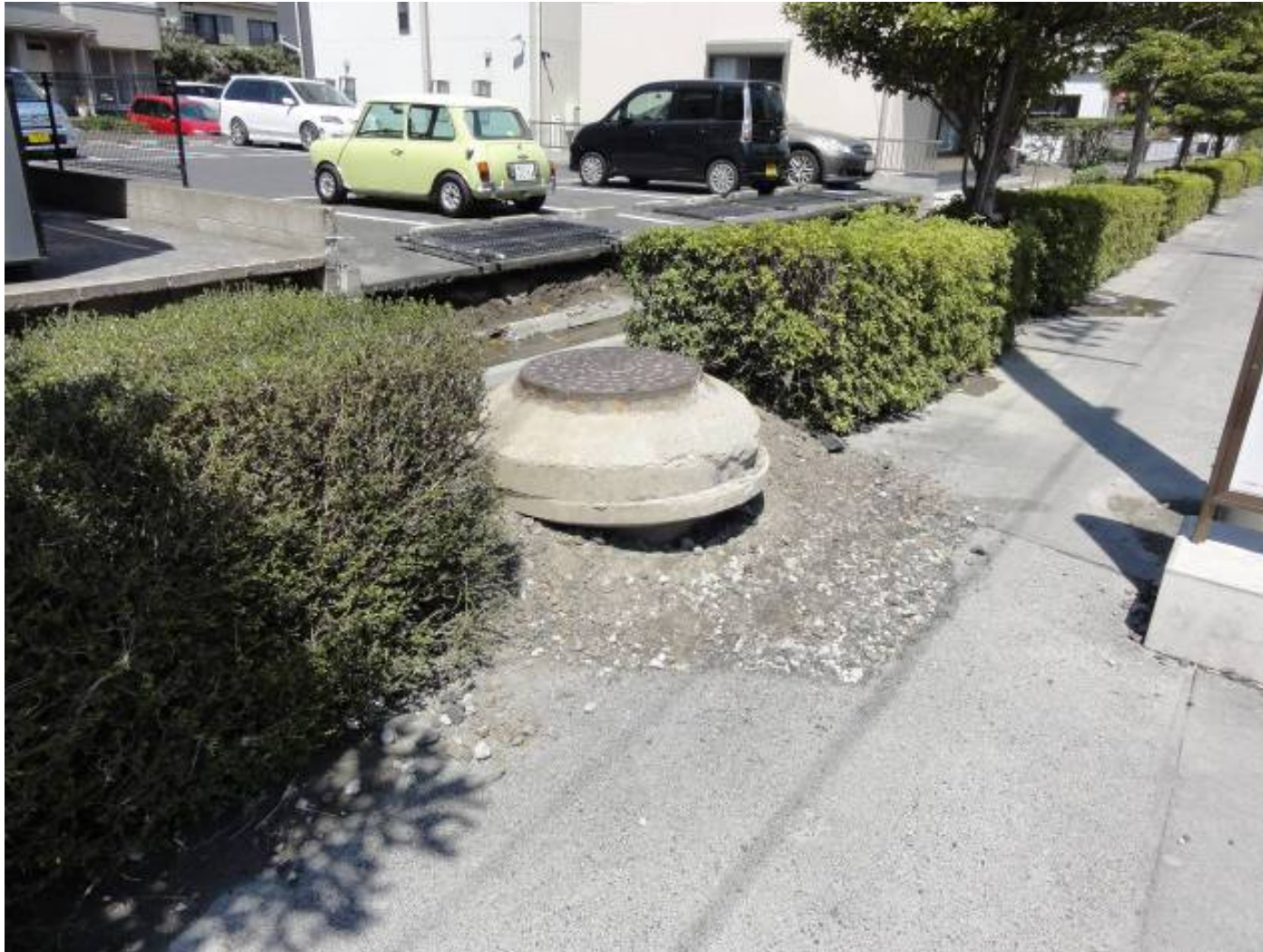
歩道部のマンホールの浮上
