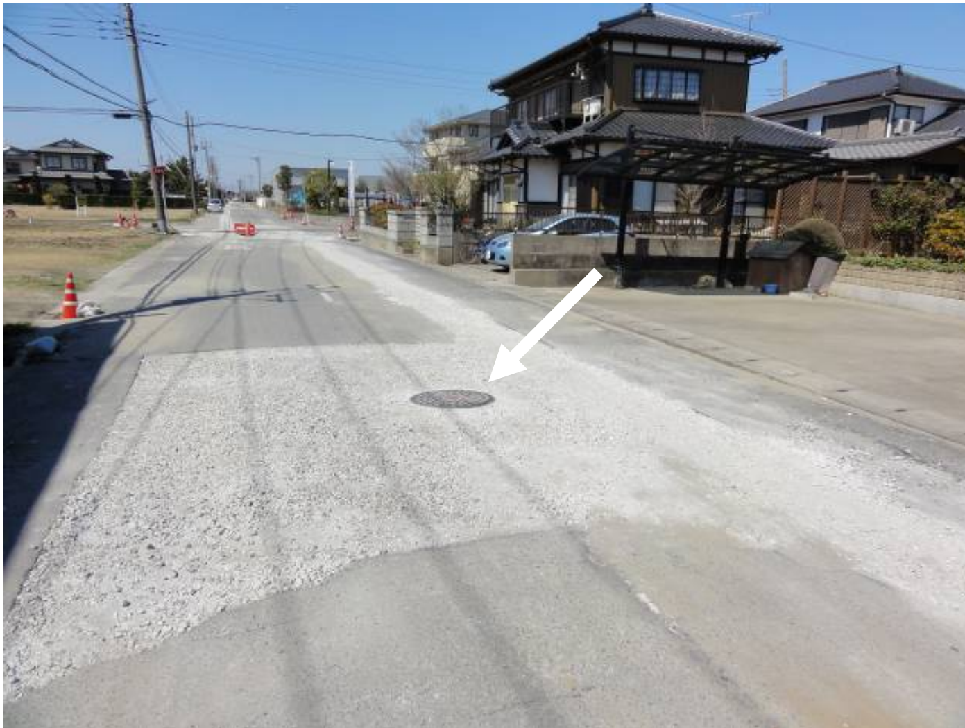
車道部のマンホール 周辺舗装修繕跡あり
