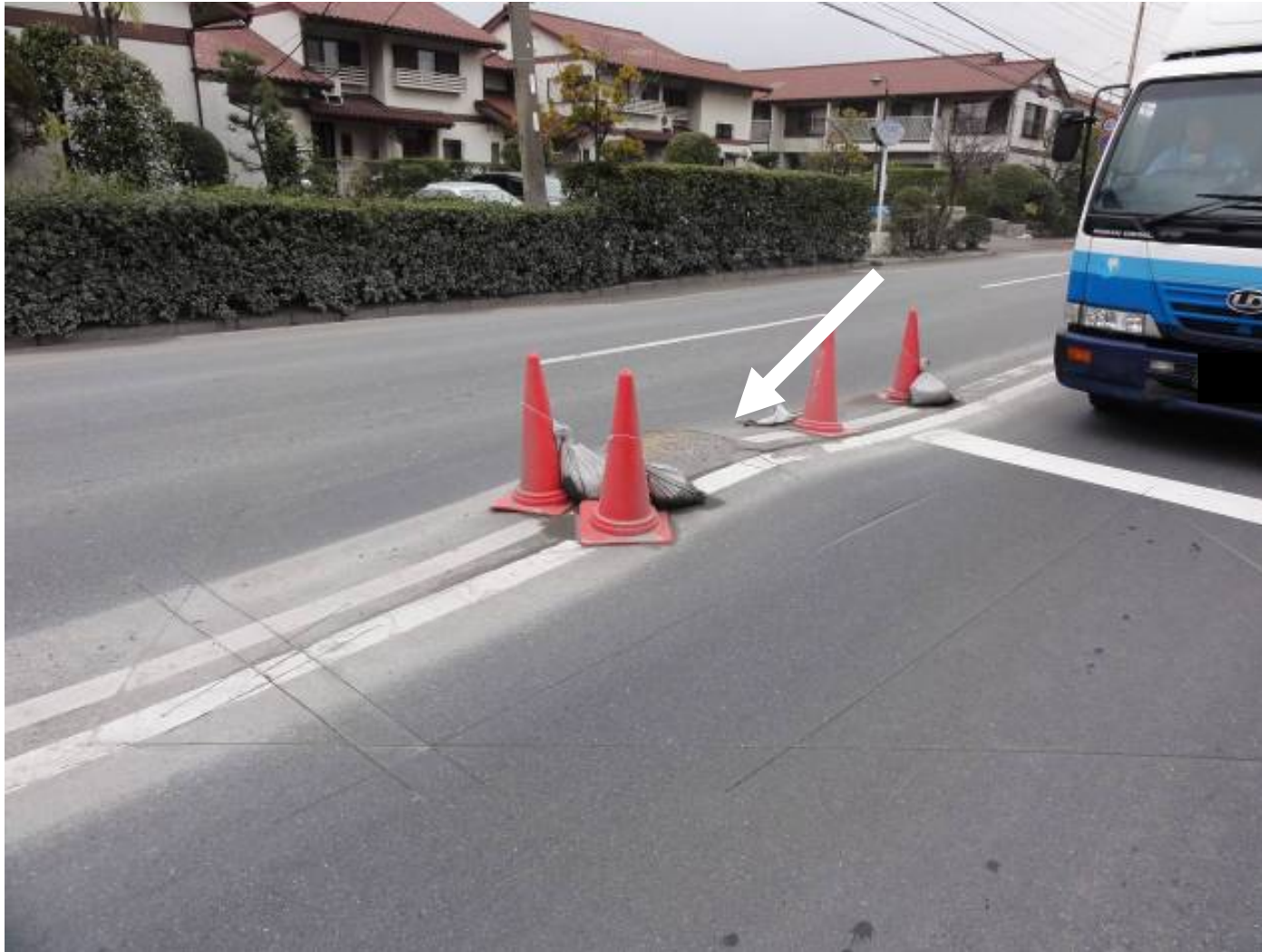
車道部センターライン付近の マンホールの隆起
