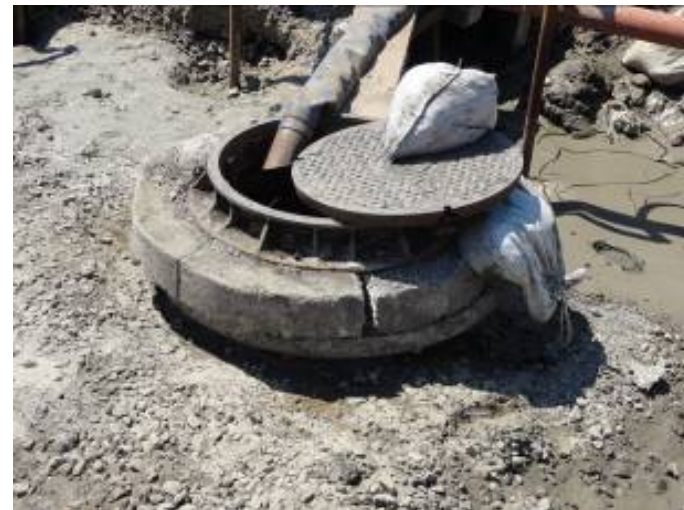
車道部のマンホール 地下水を排出
