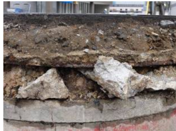
歩道部のマンホールの浮上 液状化噴砂 マンホールふたの基礎調整部が破損している
