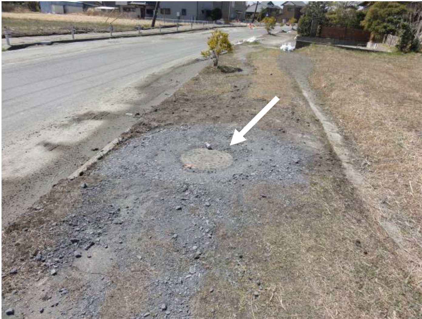
歩道部のマンホール 周辺に砂利 補修跡あり
