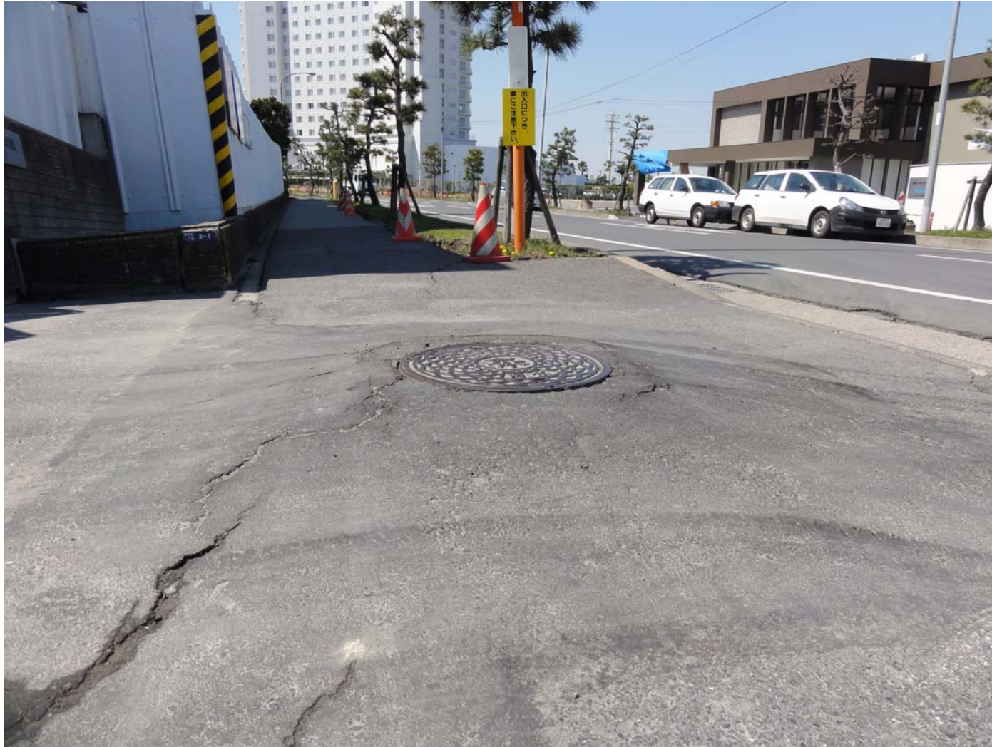
歩道部のマンホールの隆起
