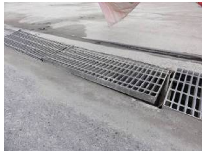
側溝のふたの浮き上がり、変形
