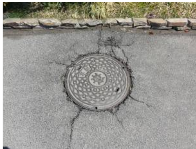
歩道部のマンホールの隆起とひび割れ
