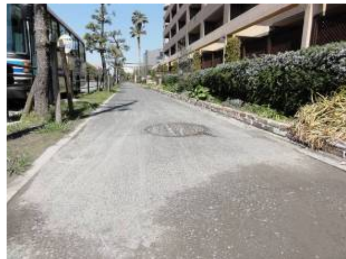
歩道部のマンホールの隆起
