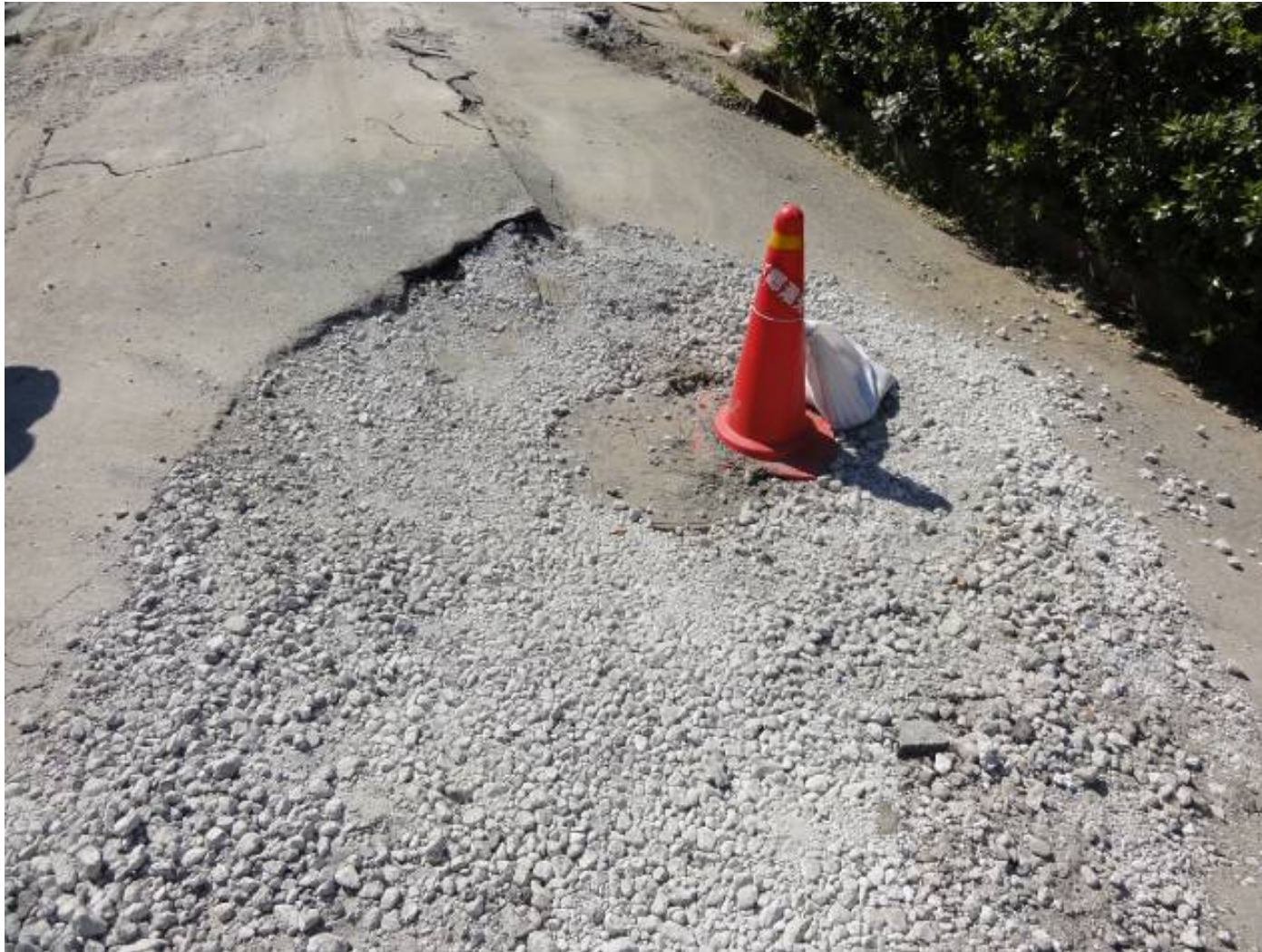
車道部のマンホール 補修跡あり
