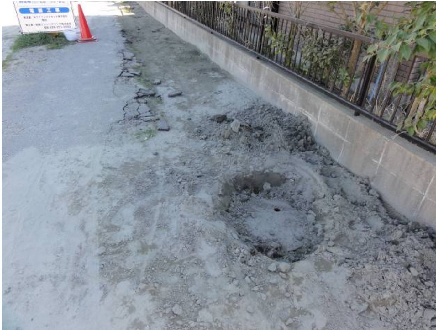
車道部のマンホール 噴砂に埋もれている
