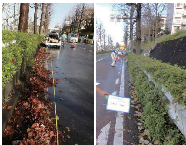
写真1：現地調査における冠水区間（左）と未冠水区間 冠水区間のますふたと側溝上には落葉が堆積
