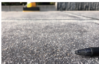
▲モジュール表面には透明な凹凸処理を施し、冬季のタイヤチェーン装着に耐えられる滑り抵抗を保持
