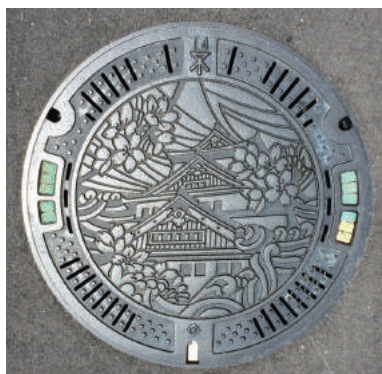
▲大阪城のマンホールふた(圧力解放耐揚圧性で飛散を防止)
