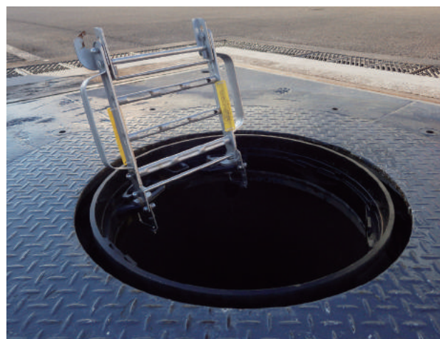
▲写真6：手持ち梯子機能を有する転落防止装置
