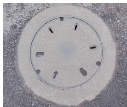
▲写真3:圧力解放耐揚圧性能のないふた
