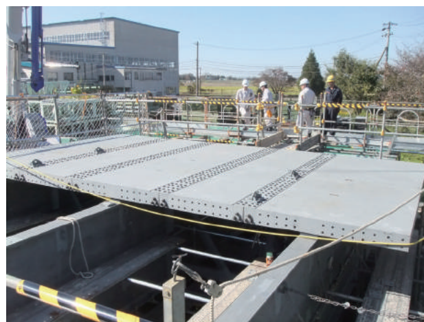
▲铸铁床版の施工性確認試験
