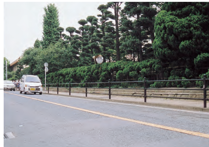
車道より高い歩道と防護柵(中学校横の歩道)
