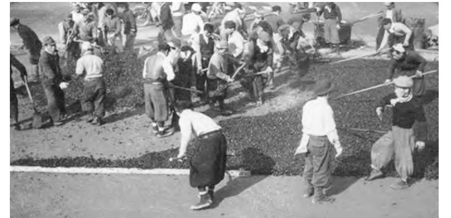
昭和31（1956）年東京国道1号（品川）セメントマカダミックス＋アスファルトコンクリート舗装
