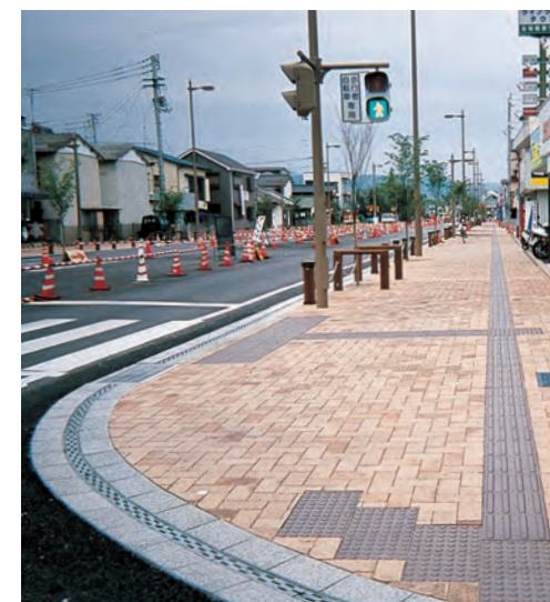
歩道舗装とのコントラストを考えたこげ茶色の点字ブロック。すりつけ勾配で段差をなくした緑石は、色と材質を変えて境目をアピール
