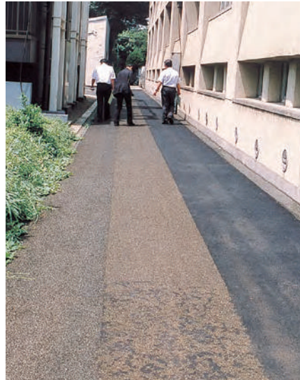
廃タイヤチップを使った弾性が異なる3舗装路
