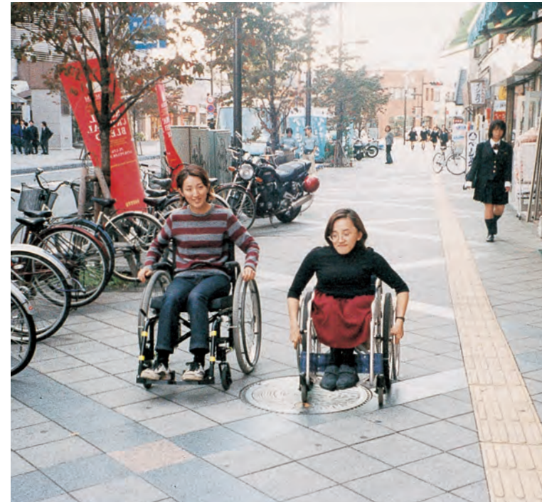
管理されている歩道。マンホールの上もスムーズに通過（国際交通安全学会調査）
