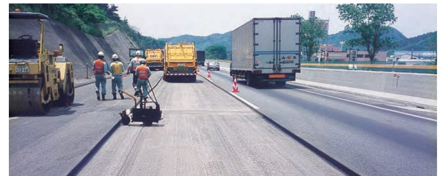
既設舗装の切削工事
