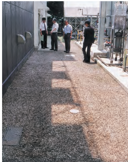
せん定した枝をごみにせず、樹木チップの舗装材にした
