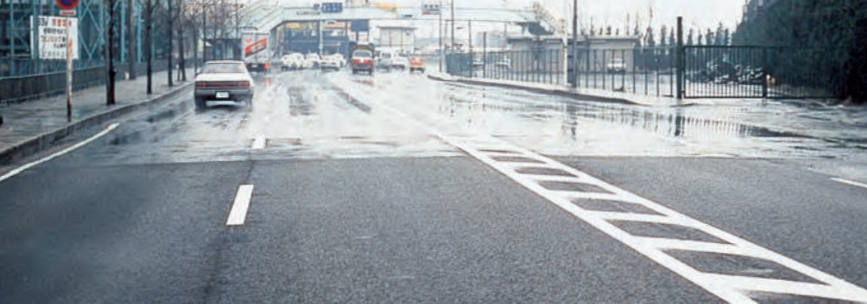
雨の日の排水性舗装 (手前) と通常舗装
