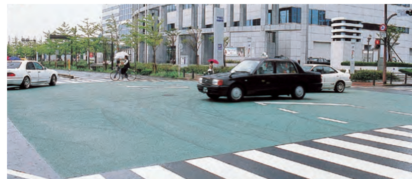
交差点に施工されたすべり止め舗装
