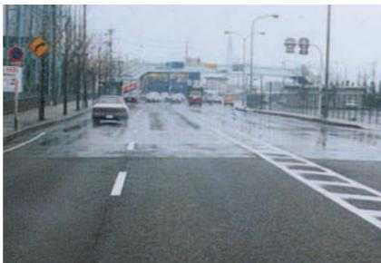
空隙率の高い透水性のアスファルト混合物を車道の表層に用いて、雨水を速やかに路面下に浸透、下層を不透水層として道路の側溝などに排水させるアスファルト舗装。水はねや水煙を防止、すべり抵抗を確保し雨天時の車両走行の安全性を高め、水膜による路面の乱反射を防いで運転手の視認性を向上し、走行に伴って発生するタイヤ路面騒音を低減する。
