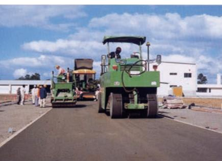
写真1 転圧コンクリート舗装 RCCP
