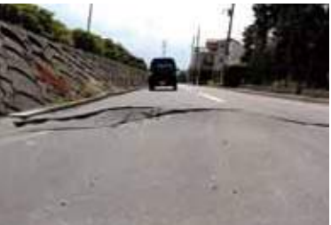
マンホールの隆起と横断方向のひび割れ
