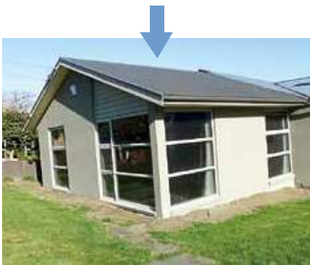
2011年6月13日の余震による再々液状化時
