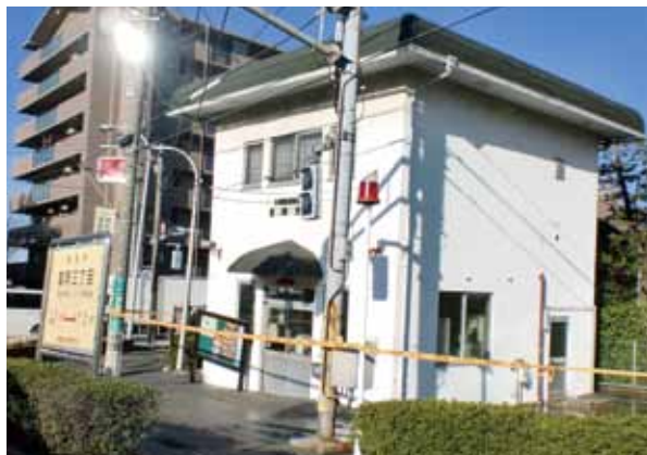
大量の噴砂や道路の突き上げで、公共の建物やバス停、電信柱などが大きく傾いている。(写真提供 大貫秀樹)
