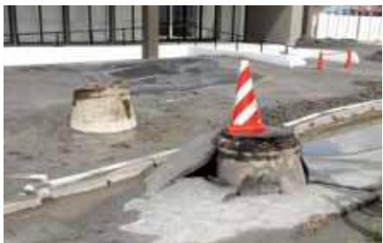
歩道部のマンホールの浮上 液状化噴砂
