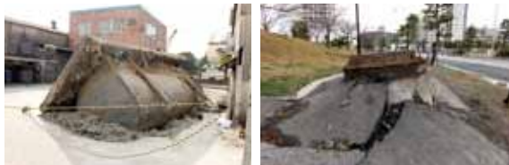
図3.液状化によるマンホール浮上のメカニズム
