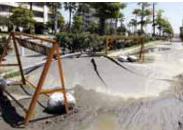
歩道部のマンホールの浮上 放射状のひび割れ
