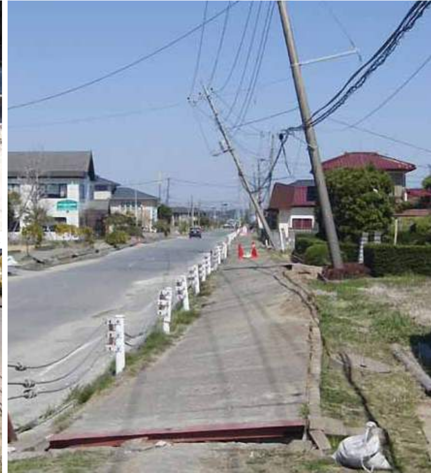
▼道路によって突き上げられた管きょ
