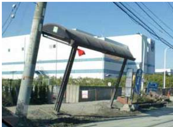
大量の噴砂や道路の突き上げで、公共の建物やバス停、電信柱などが大きく傾いている。(写真提供 大貫秀樹)
