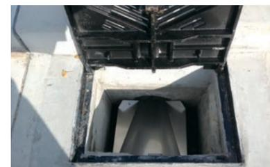
写真1: 新開発したインパートの設置状況
