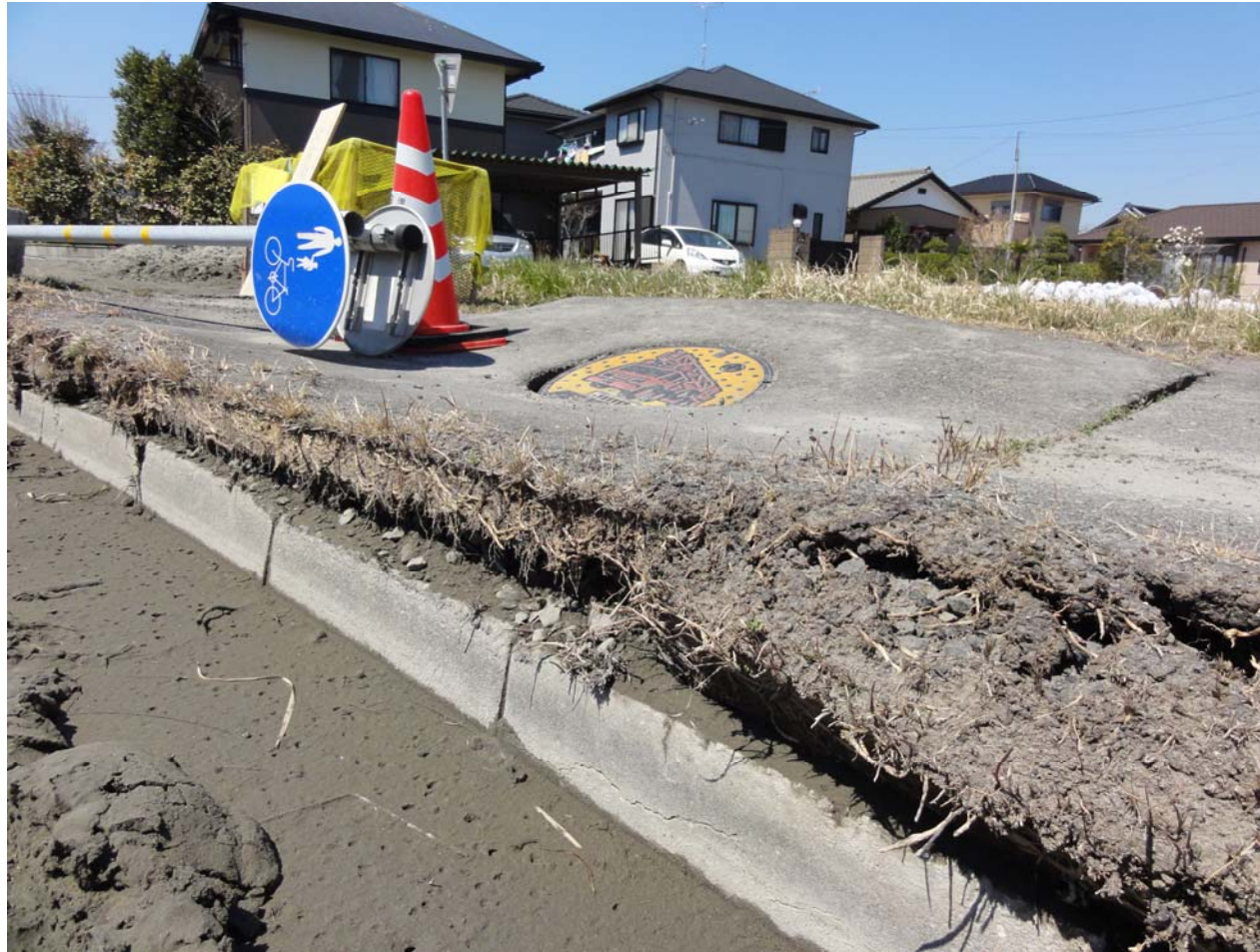
歩道部の消火栓ボックスの陥没 潮来市日の出
