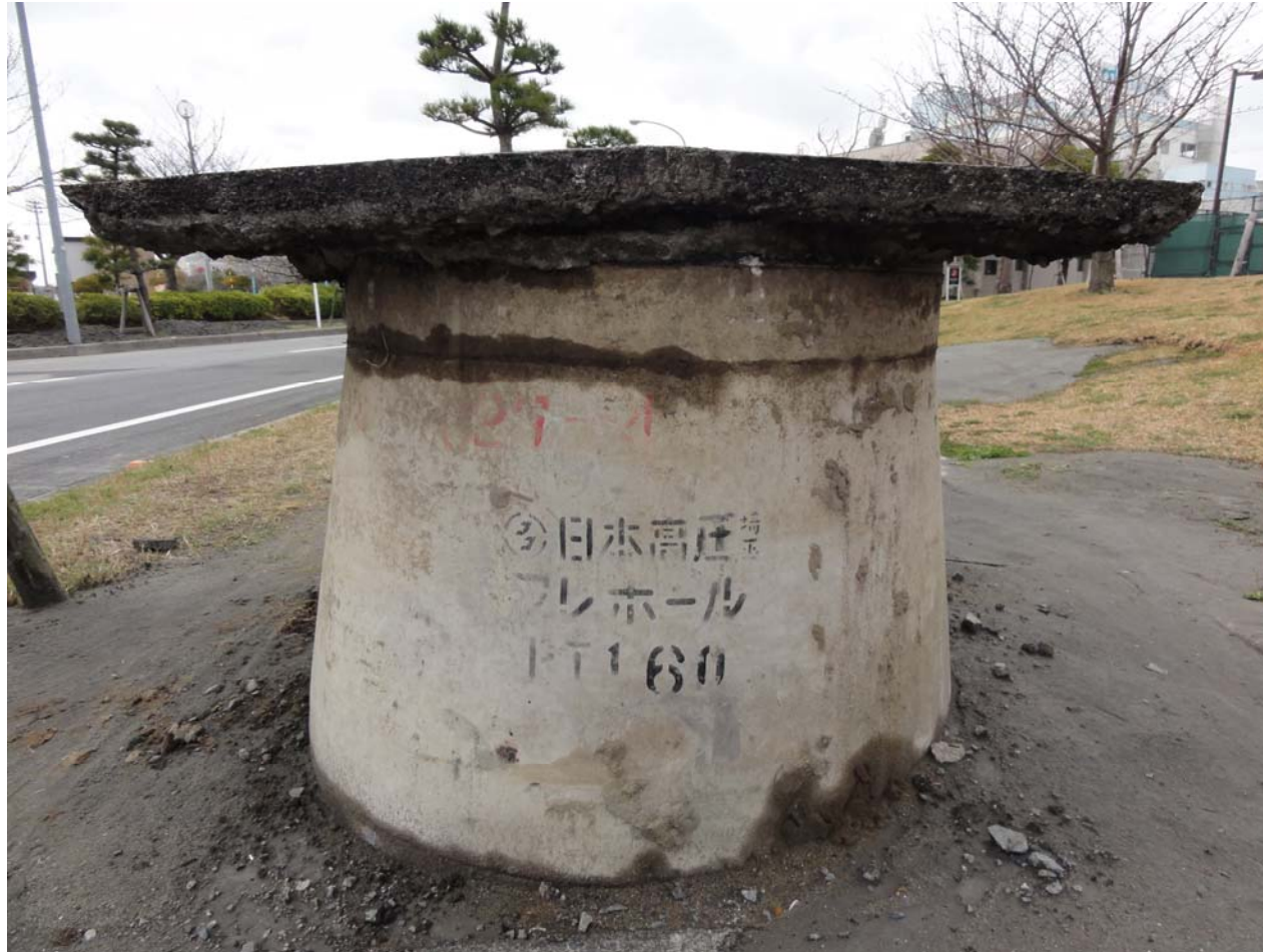
歩道部の下水道用マンホールの浮上 浦安市明海
