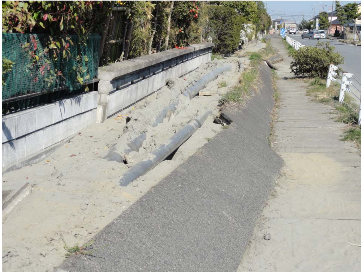
管渠(汚水、水道)が浮上 潮来市日の出
