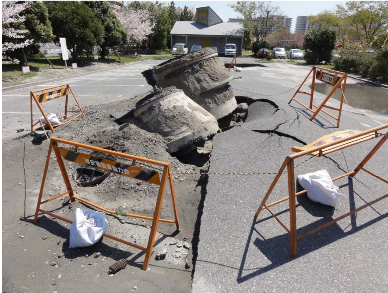
耐震性貯水槽のマンホールの浮上 浦安市高洲
