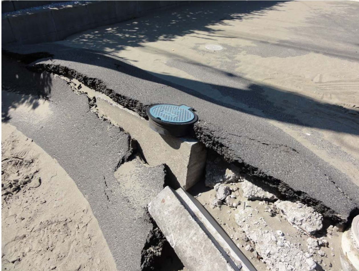
止水栓ボックスの破損 浦安市日の出
