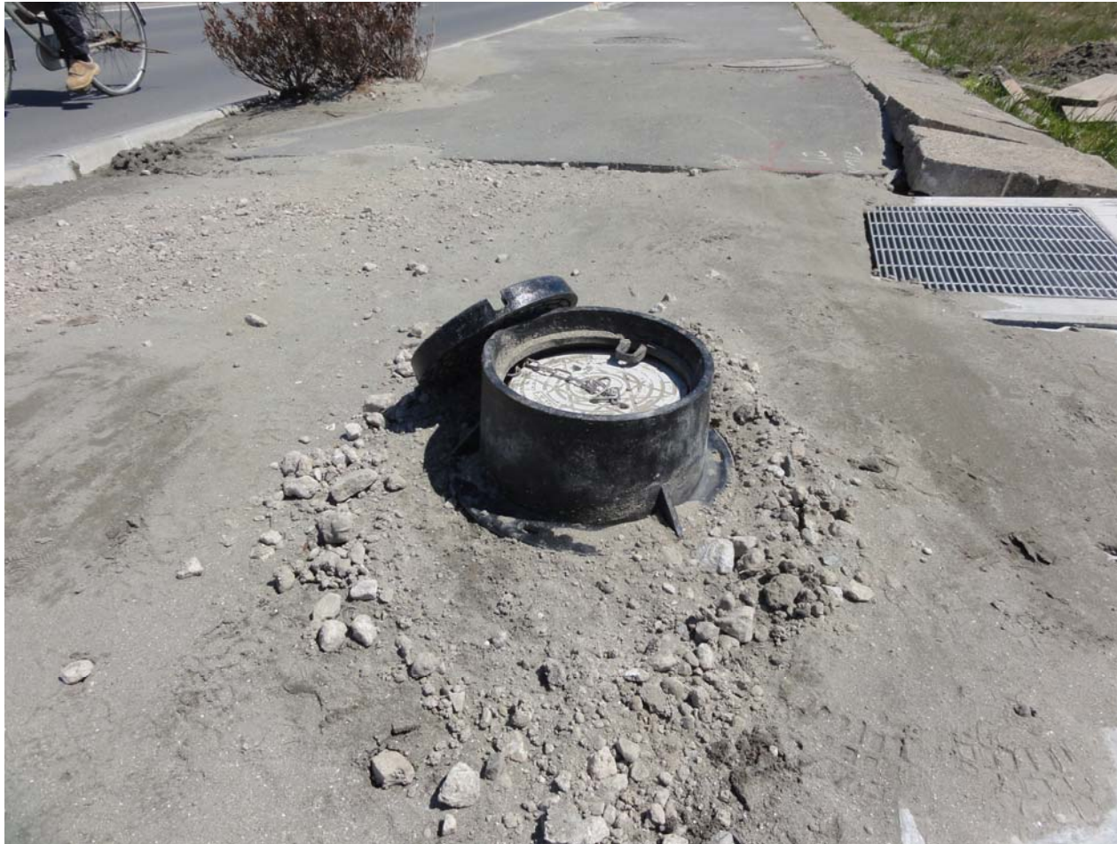
歩道部の小型防護ふたマンホールの浮上 潮来市日の出
