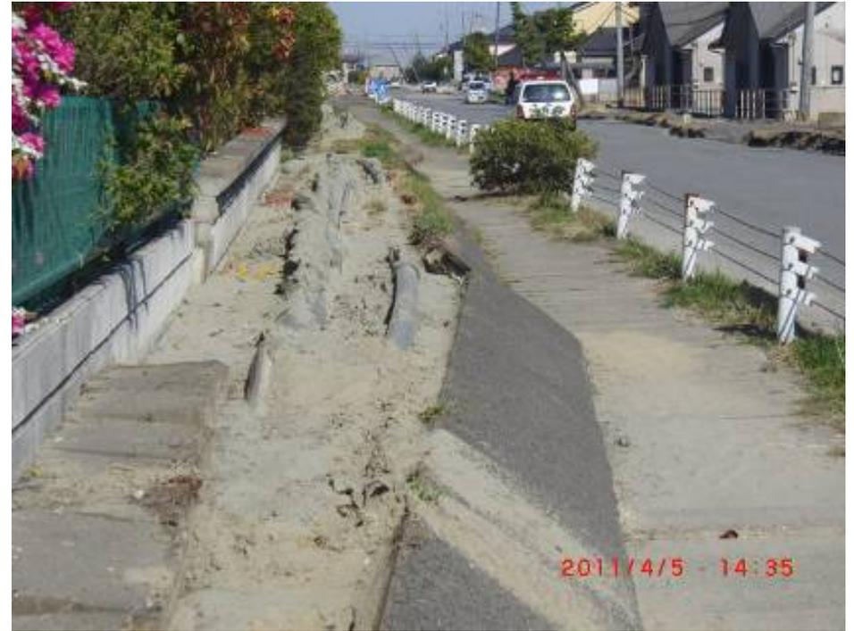
管渠(汚水、水道)が浮上、側溝が壁側にある
