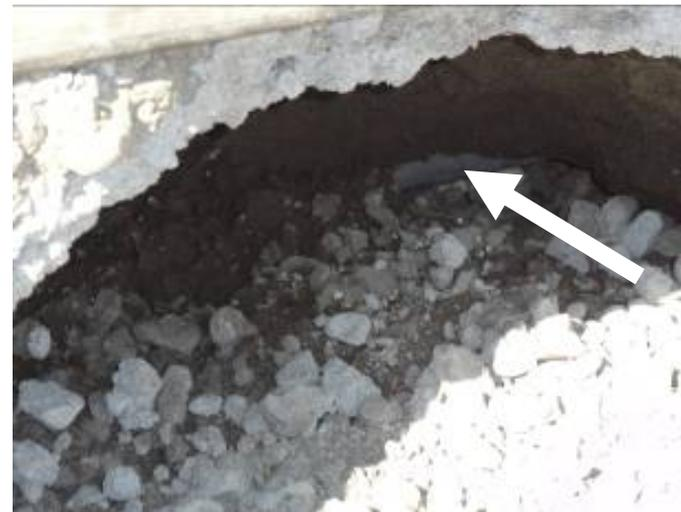
車道部のマンホールの横 舗装陥没
