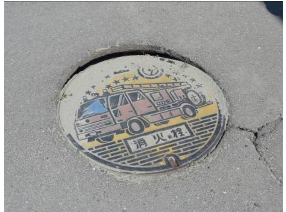
歩道部の消火栓ボックスの陥没
