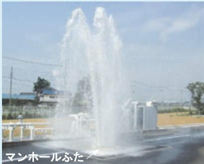
マンホールふた 集中豪雨等を想定したふたからの噴水
