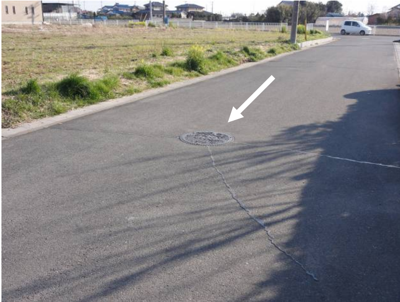
横断方向のひび割れ 充填補修跡あり
