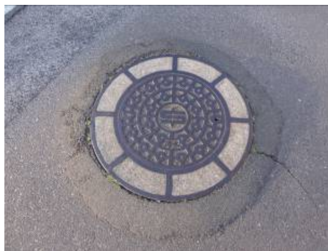
歩道部のマンホールの隆起
