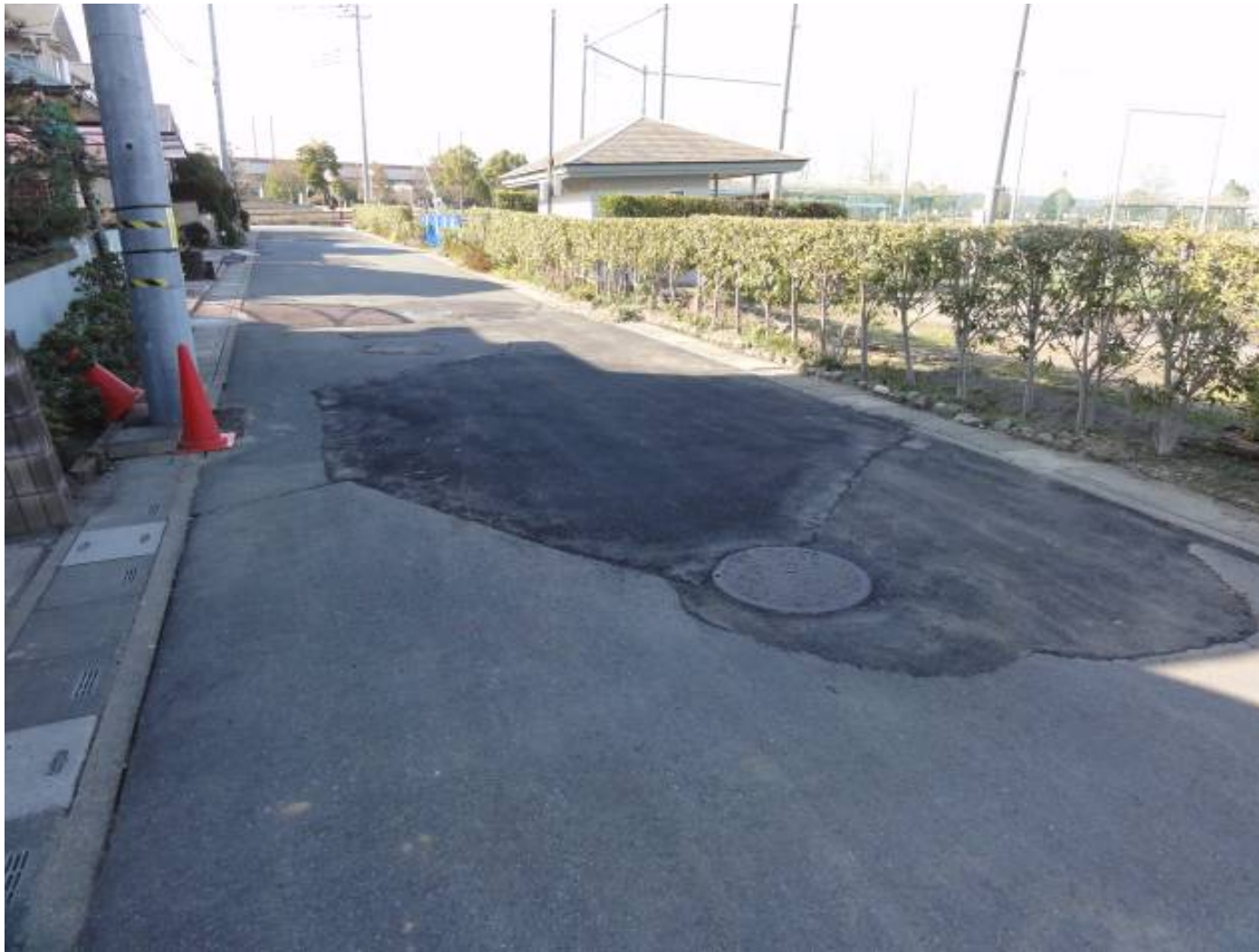
車道部のマンホール周辺舗装の破損 補修跡あり
