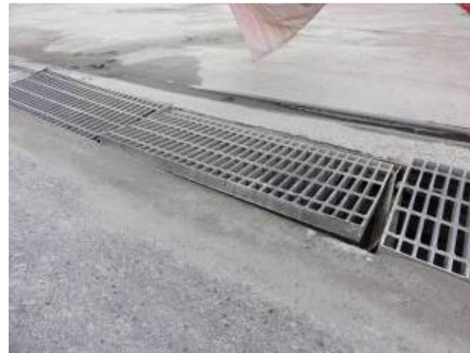
側溝のふたの浮き上がり、変形
