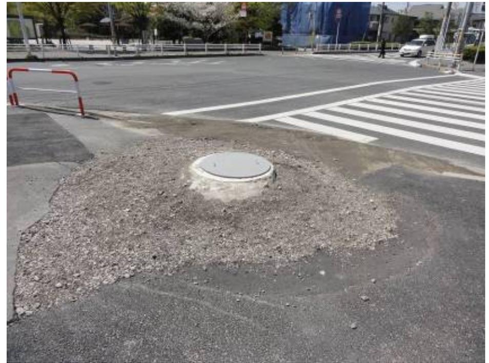
歩道部のマンホールの浮上 仮設ふたが設置されている
