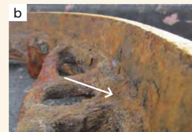
▲枠勾配面の腐食生成物堆積
